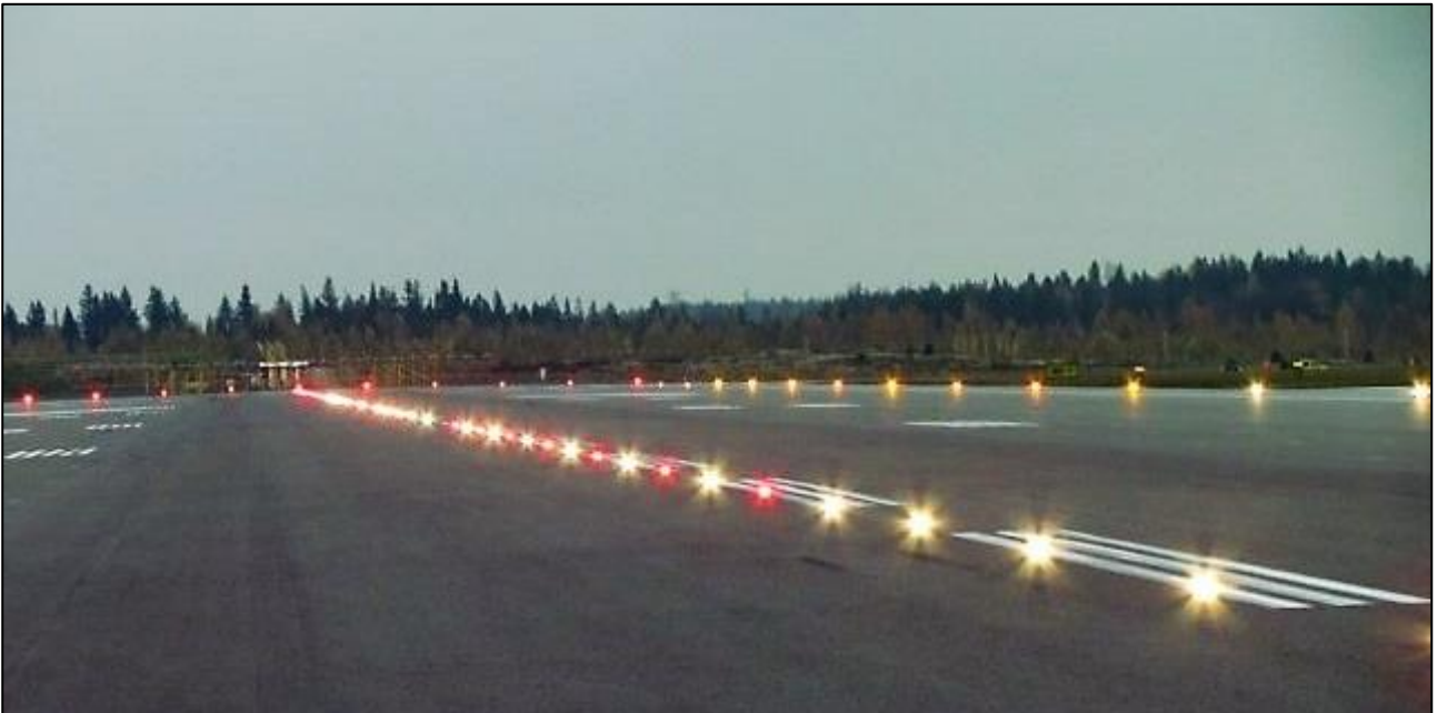
Kuva 3. Kiitotie keskilinjavalot vaihtuvat punavalkoisiksi 900 metriä ennen kiitotie päätä. (Kuva: OTKES)
