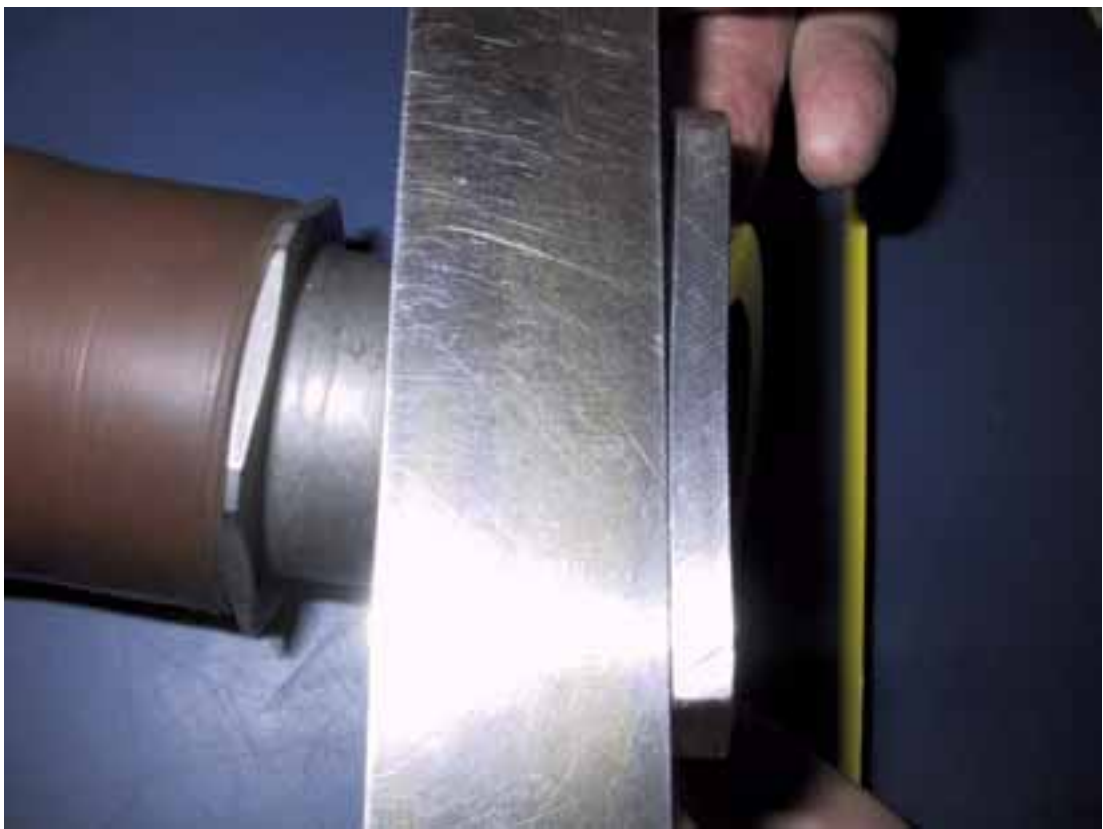
Kuva 2. Taipunut polttoaineen syöttöputken irtolaippa.
