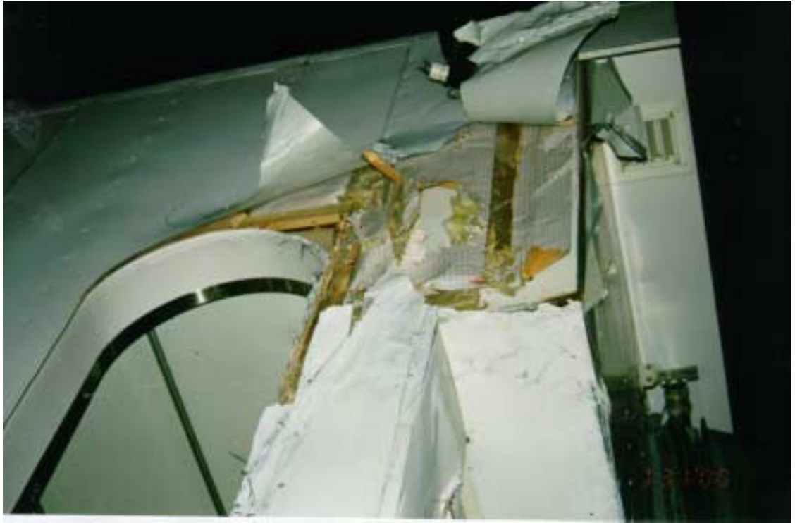
Kuva 2. Matkustajasillan seinäverhous ja ikkuna rikkoutuivat.
