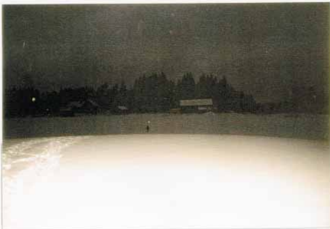
Kuva 1. Vauriopaikka sijaitsi pellon keskellä olevalla kumpareella.
