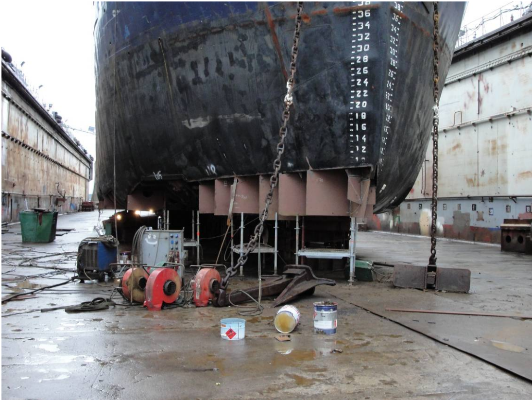
Kuva 5. Vaurioituneet pohjalevyt on kuvassa poistettu ja uudet jäykistäjät hitsattu telakalla Tallinnassa.
