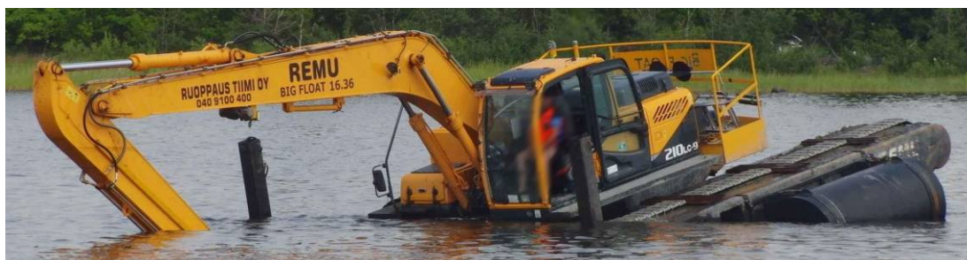
Kuva 9a. Kaivinkone hieman lähdön jälkeen noin klo 13.35.
