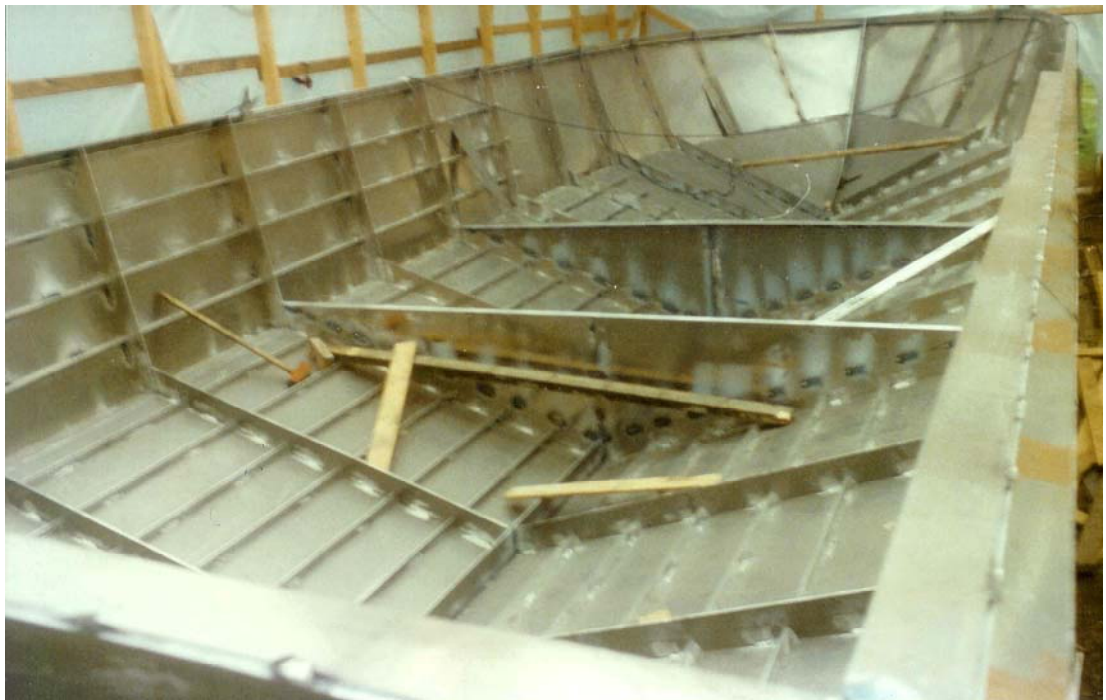
Fig. 5b. Ursprungliga konstruktionen sett mot fören. (fig: MS MIIRAs byggare)
