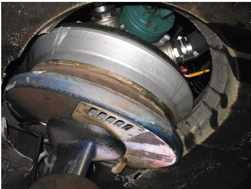
Fig. 16b. Öppningen i botten vid högra drevets genomföring. O-ringar är ur sina platser, se bilaga 1, figur 5.
