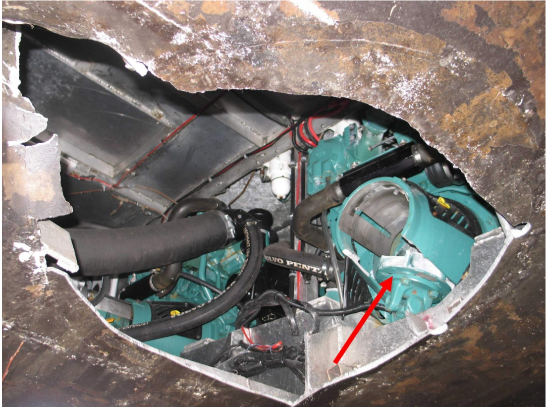
Kuva 1. Leikattu aukko IDA 1:n pohjassa vetolaitteen irrottamisen jälkeen. Nuoli osoittaa murtuneen akselikytkennän.
