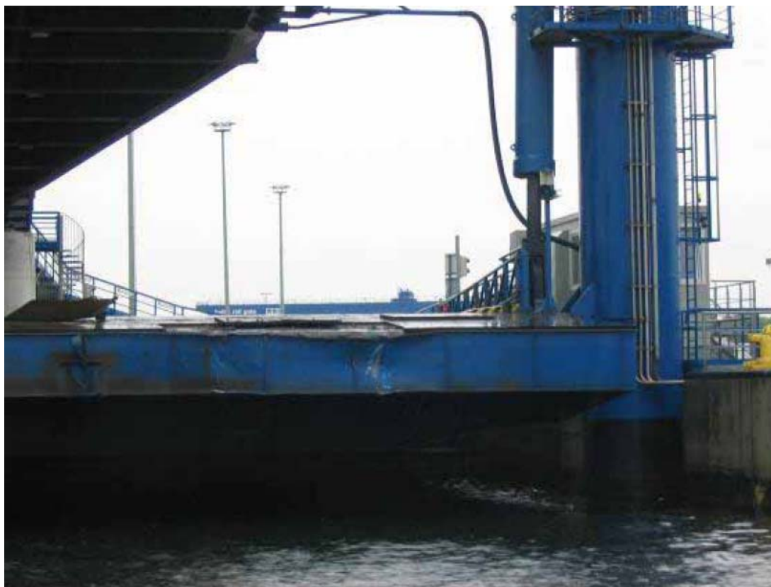
Bild 20. Skador på kajrampen.
