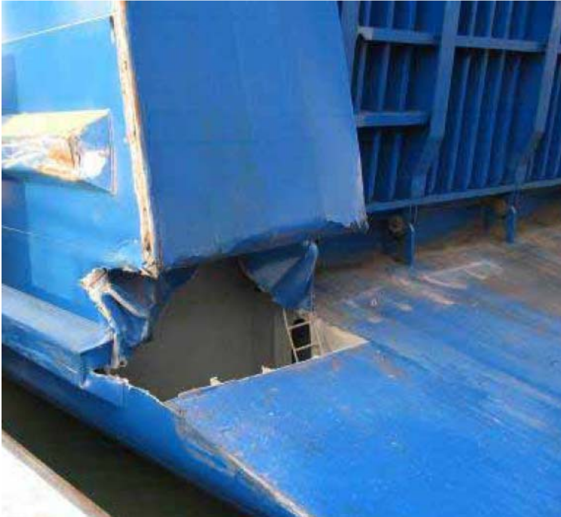
Bild 19. Det skadade akterutskottet på MS FINNLADY.
