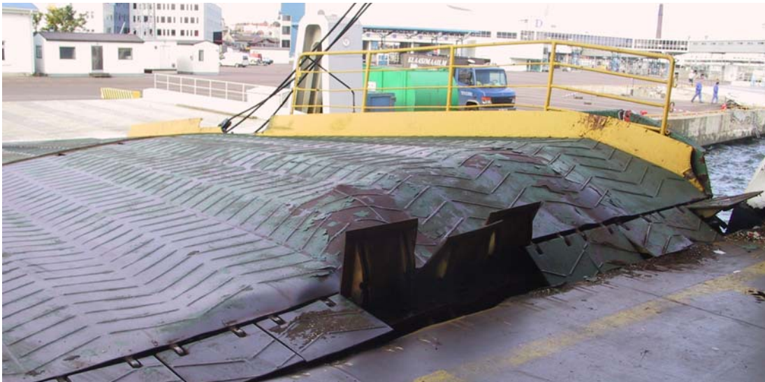
Bild 18. Den skadade akterrampen på MS TRANSLANDIA.
