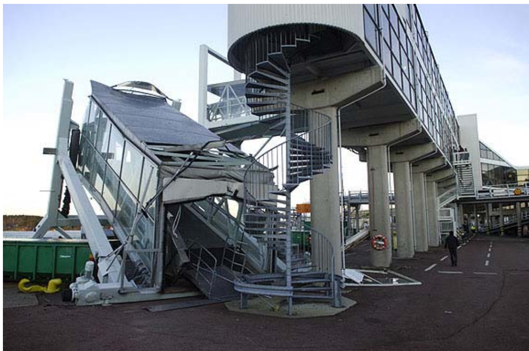
Bild 14. Den skadade landgången. Hamnbassängen syns baktill i den vänstra kanten av bilden. (Copyright Ålandstidningen)
