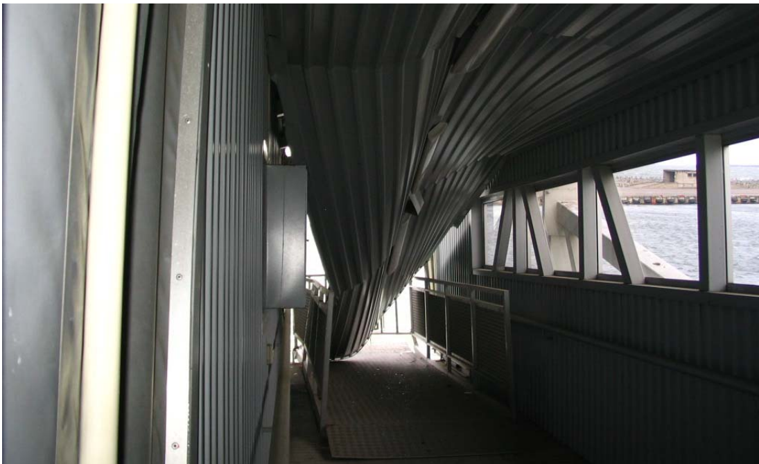
Bild 17. Landgångens tak som fallit ned.
