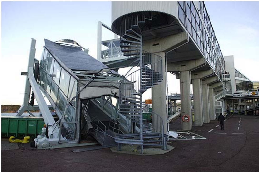
Kuva 14. Vaurioitunut maihinnoususilta. Satama-allas näkyy kuvassa taustalla, vasemmassa reunassa. (Copyright Ålandstidningen)
