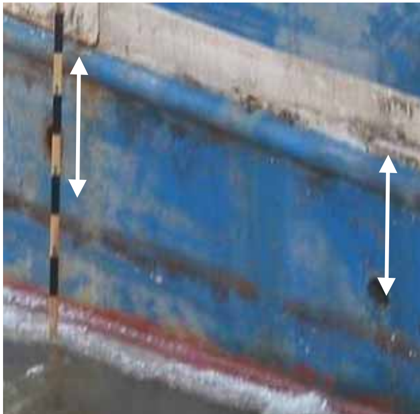
Kuva 6. Pumpun poistoaukon sijainti. Aukon keskipiste on noin 35 cm kannen alapuolella. Kuva Beacon Finland Ltd Oy:n mittauksista kallistuskokeen aikana 29.12.2004. Kannen reuna on 3,5 m korkeudella perusviivasta.
