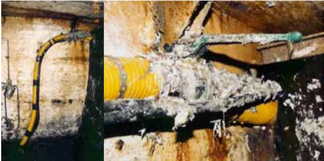
Kuva 7. Vasemmalla poistoputken kulku peräruuman perälaipiolla. Oikealla palloventtiilin vipu auki-asennossa. Noston jälkeen venttiiliä ei ole puhdistettu
