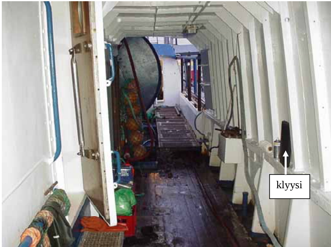
Kuva 4. SEA GULLin oikean laidan käytävä. Kansirakennukseen ja keulapakkaan vievät ovet ja kynnykset ovat näkyvissä. Kansirakennuksen ovenssa on ikkunaventtiili. Oikealla klyysi.
