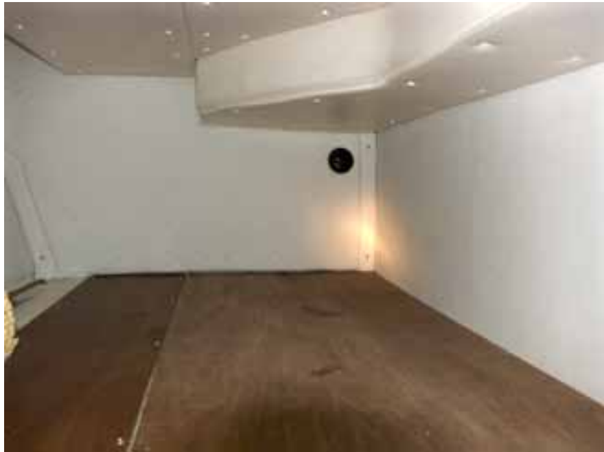
Kuva 11. Konetilan laipiossa oleva lämmityslaitteen puhallussuuttimen läpivienti. Kuva on otettu asuintilan puolelta talvella 2004.
