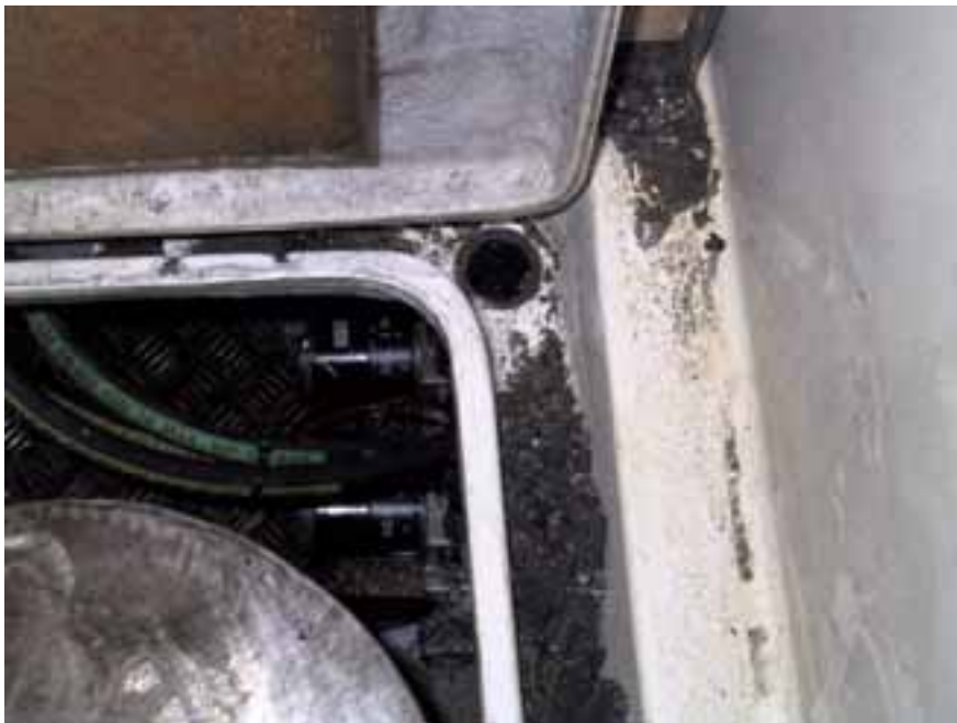
Kuva 3. Sama vesikourun peränurkka onnettomuuden jälkeen ennen veneen korjausta. Kuvasta näkyy, että onnettomuuden sattuessa ei luukussa ollut tiivistettä eikä sen rakenne ollut vesitiivis muuten kuin sadeveden osalta, jonka kouru johti tyhjennysputkea pitkin ulos.
