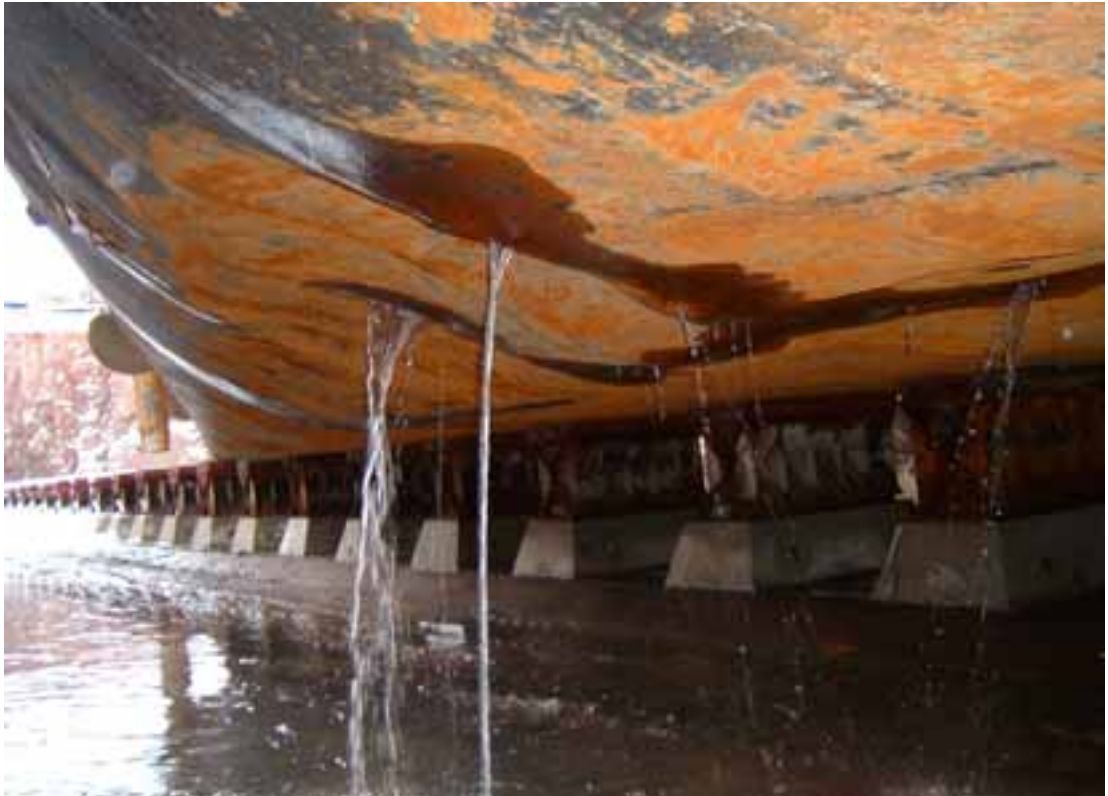
Kuva 5. BIANCAN runkovaurioita kuvattuna telakalla Maarianhaminassa.
