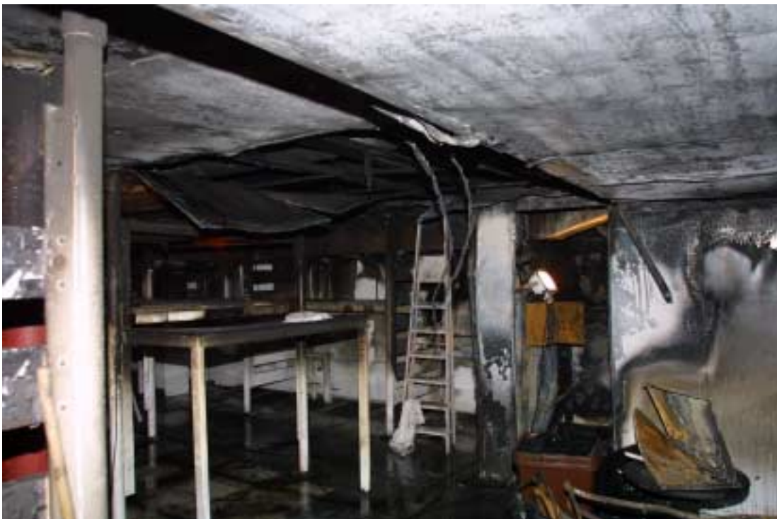
Kuva 8. Tax-free-varasto. Keskuspölynimurihuoneen oviaukko tikkaiden oikealla puolella.
