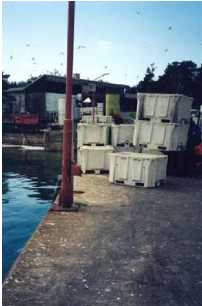
Kuva 13. Laupusten kalasataman laituri, pylväässä sähköpistoke.
