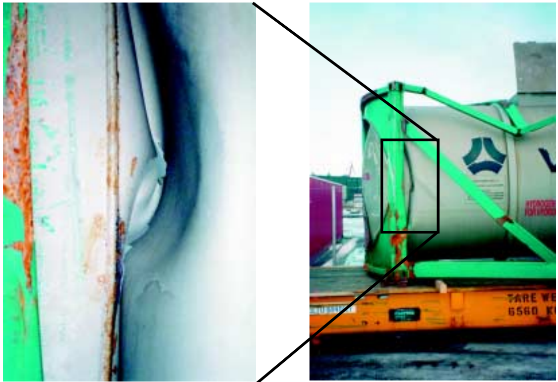
Kuva 8. Säiliökontin vuodon aiheuttanut vaurio
