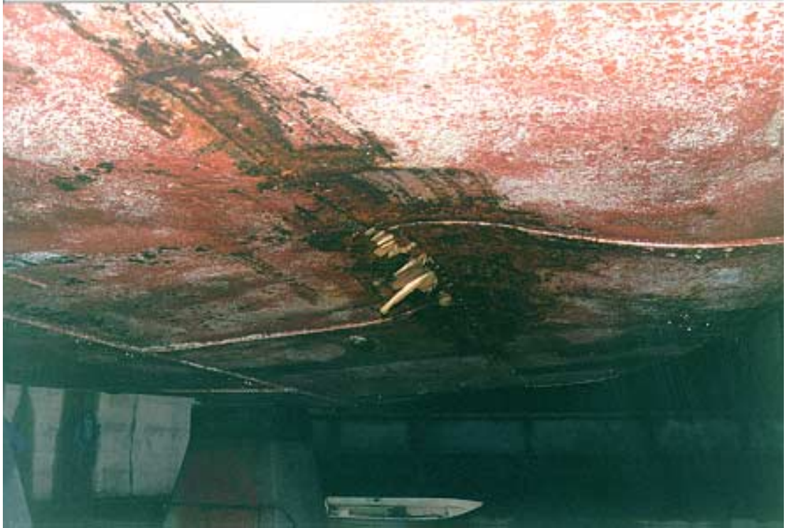
Kuva 5. Toisen iskun aiheuttama painuma ja niittisauman repeämä aluksen oikealla puolella. Vuotokohta on tukittu aluksen sisäpuolelta lyödyillä puukiiloilla.
