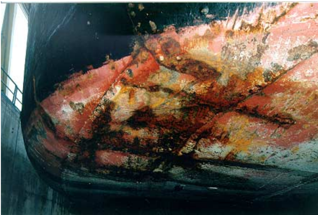
Kuva 4. Ensimmäisen iskun aiheuttama painuma. Kuvan vasemmassa reunassa vesirajassa on hitsaamalla korjattu repeämä.
