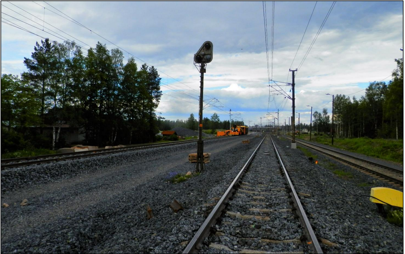
Kuva 5. Kuva vaihteelta V114 pohjoiseen kohti Ylivieskan asemaa. Rakenteilla oleva läntinen kaksoisraide on kuvassa vasemmalla. Ratatyökone rullasi kuvassa keskellä näkyvää raidetta Ylivieskan asemalle. (Kuva: OTKES)
