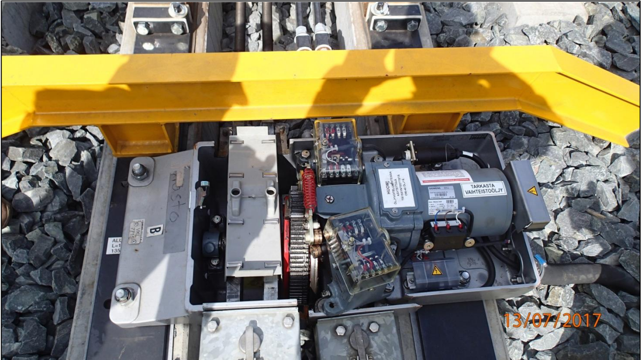
Kuva 7. Vaihteen V114 rikkoontunut kääntölaite. (Kääntölaitteen kansi on kuvassa avattu.) Kääntölaitteen runko on murtunut ja samalla vaihteen tilaa ilmaisevien rajakytkimien kiinnike on irronnut rungosta. (Kuva: OTKES)
