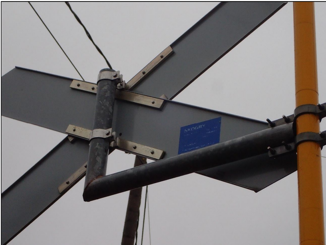
Kuva 6. Varoituslaitteettomissa tasoristeyksissä ratakilometri ilmoitetaan tasoristeysliikennemerkkin takana pienellä tarralla. Onnettomuustasoristeyksessä tarra oli haalistunut. (Kuva: OTKES)
