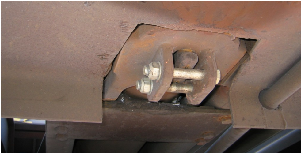
Kuva 4. Vetokiilan kunnossa oleva kiinnitys vaunun toisesta päästä. Myös siitä vetosangasta puuttuu hylly, joka estää ruuvin putoamisen mutterin irrotessa.
