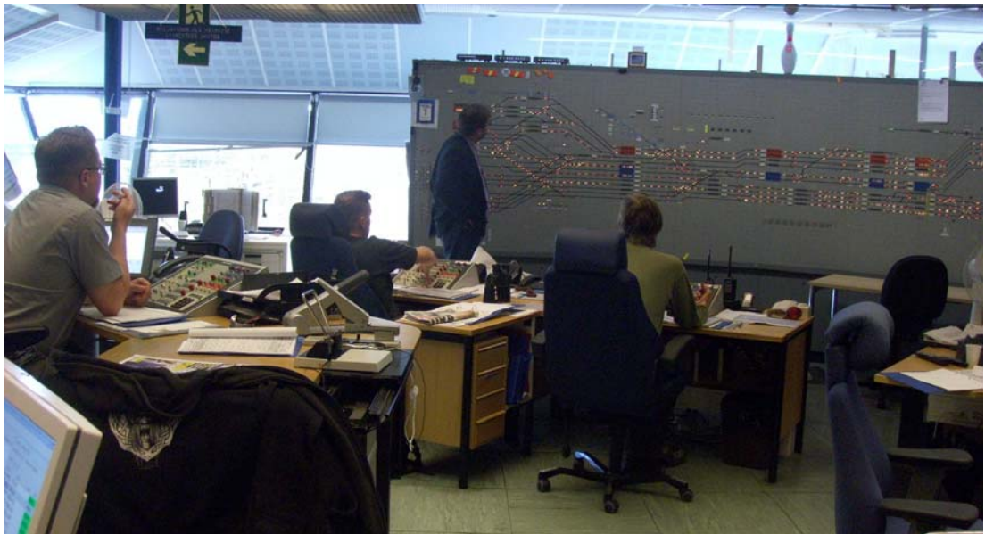
Kuva 11. Asetinlaitemiehet antavat junien ohjaukseen liittyviä komentoja edessään olevilla ohjauslaitteilla. He seuraavat junien liikkeitä isolta ilmaisintaululta. Pääradan puolen liikenteenohjaajan työpiste sijaitsee asetinlaitemiesten työpisteen takana, kuvassa vasemmalla.
