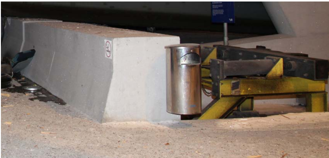
Kuva 10. Viereisen raiteen betonieste ja hydraulinen raidepuskin.
