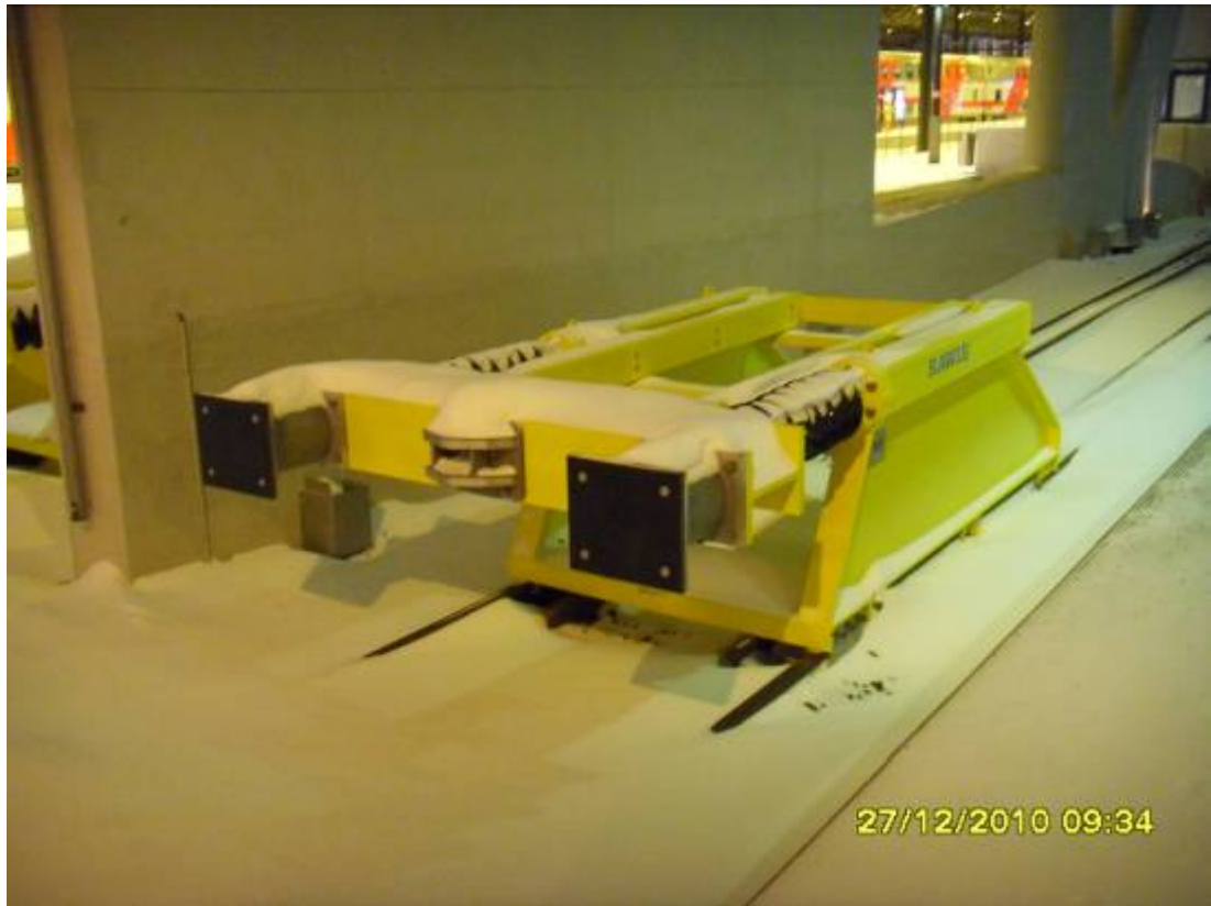
Bild 19. Ny spårbuffert på spår 13.
