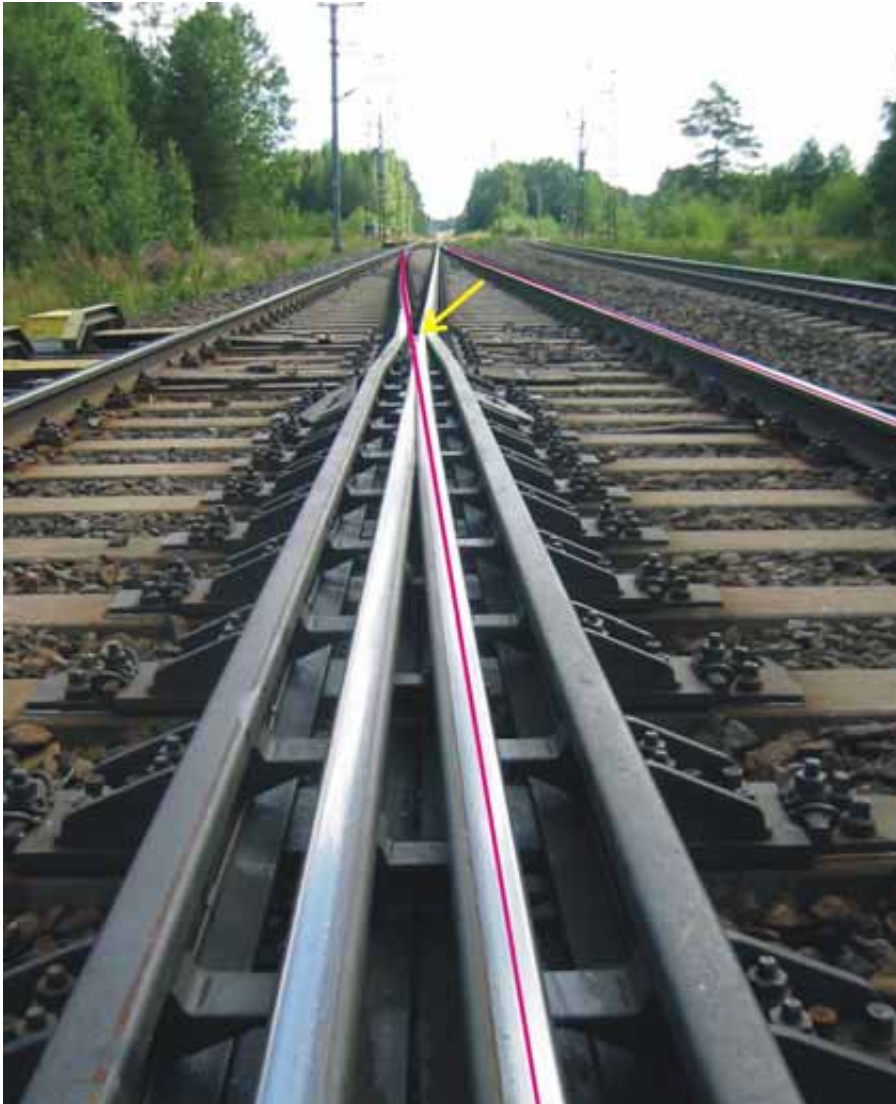
Kuva 5. Vaihteen V002 kääntyväkärkisen risteuksen asento vaihteen ollessa suoralle raiteelle johtavassa asennossa. Junan kulku vaihteen kieliin eteen on kuvattu punaisilla viivoilla. Keltainen nuoli näyttää kääntyvän risteuksen.
