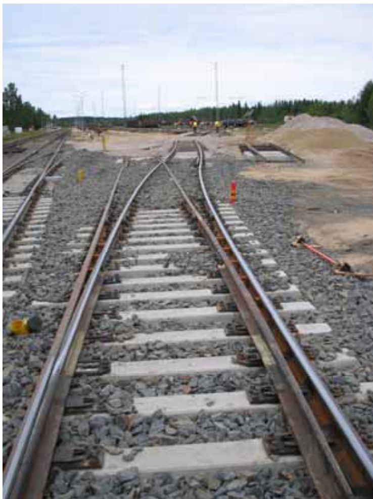
Kuva 3. S-kaarre katsottuna junan kulkusuuntaan. Etualalla vaihde V049.
