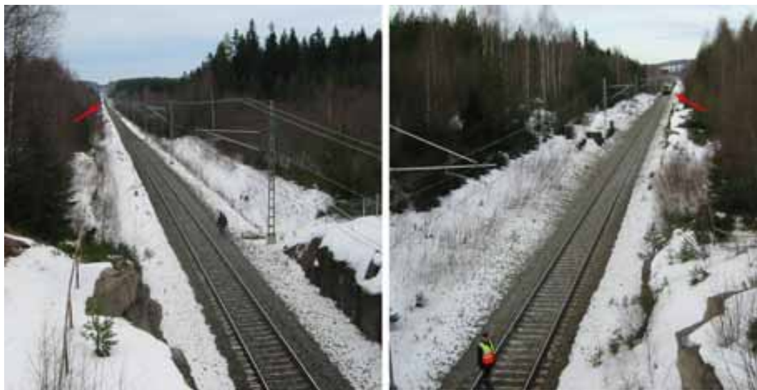
Kuva 2. Suistumiskohta on vasemmassa kuvassa nuolen osoittamassa kohdassa. Pysähtyneen junan kaksi viimeistä vaunua näkyvät oikeassa kuvassa.
