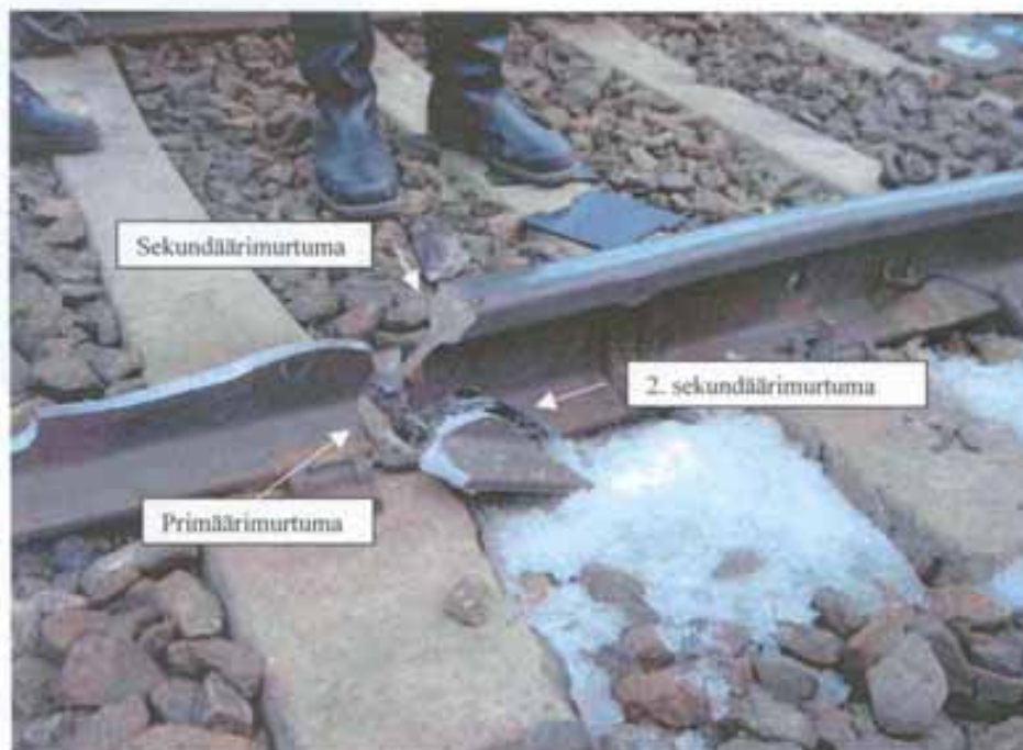
Kuva 2. Yksityiskohtaisempi kuva vauriokohdasta.
