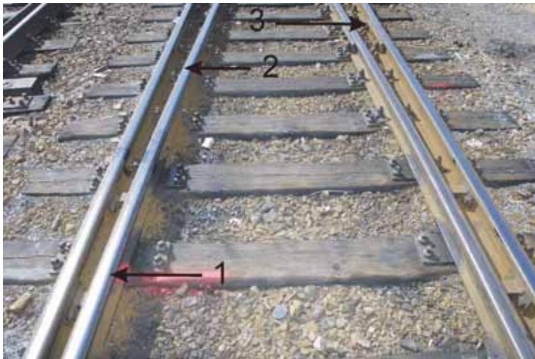
Kuva 3. Vasemman pyörän laippa nousi kiskolle kohdassa 1 ja putosi alas kohdassa 2. Kiskolta pudonnut oikea pyörä vaurioitti kiinnitysputteja alkaen kohdasta 3.
