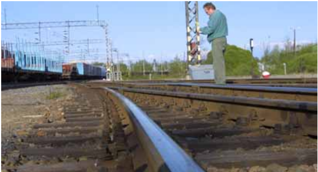
Kuva 4. Kiskossa ollut korkeuspoikkeama.
