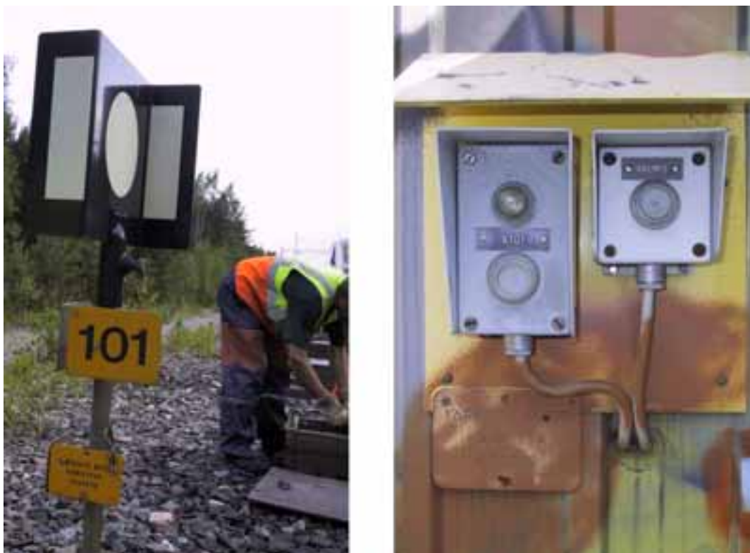
Kuva 7. Vaihteen opastinlevyn yhteydessä on lisäkilpi, joka muistuttaa risteyksen asennon tarkistamisesta. Samansisältöinen kilpi on myös paikalliskääntöpainikkeen luona, tosin se on ilkeilyltä sotkettu. Kilvissä on teksti "TARKISTA MYÖS KÄÄNTYVÄ RISTEYS".
