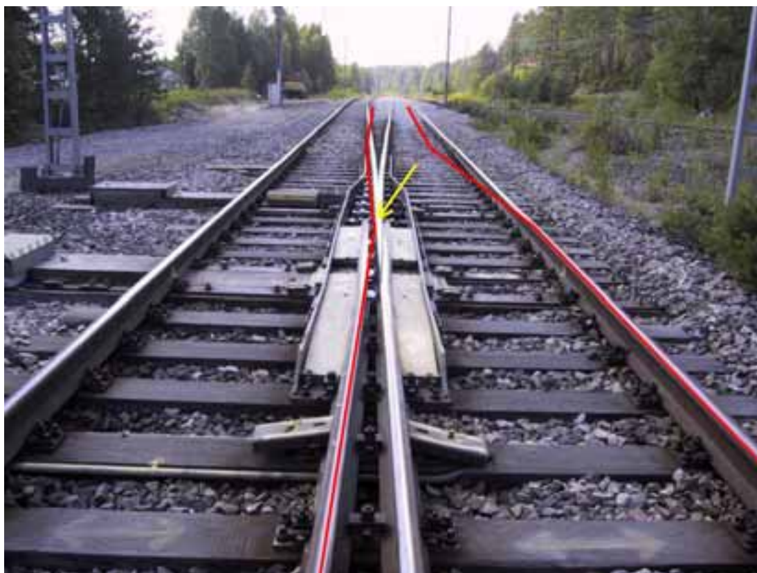
Kuva 6. Vaihteen V101 kääntyväkärkinen risteys junan tulosuunnasta kuvattuna radan korjauksen jälkeen. Kuvauspaikan takana olevat vaihteen kielet ohjasivat junaa oikeanpuoleista kiskoparia pitkin suoraan. Risteys oli kuitenkin kuvan osoittamalla tavalla vasemmalle johtavassa asennossa. Pyörien kulku on merkitty kuvaan punaisella viivalla ja risteuksen kääntyvä kärki keltaisella nuolella.
