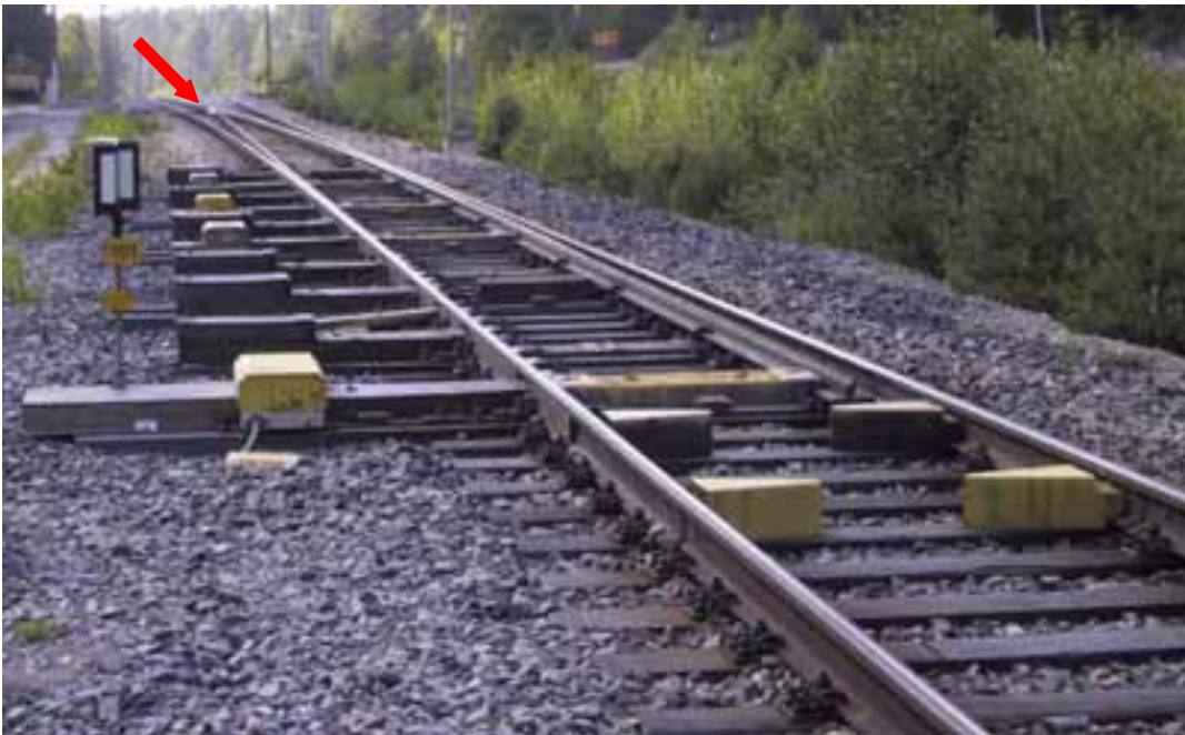
Kuva 3. Vaihte V101 Helsingin suunnasta kuvattuna. Kielen kärjet olivat suistumislanteessa kuvan osoittamalla tavalla suoraan johtavassa asennossa. Kauempana, nuolella merkityssä kohdassa on vaihteen kääntyväkärkinen risteys. Risteystä ja sen toimintaa on havainnollistettu tarkemmin kuvissa 5 ja 6.
