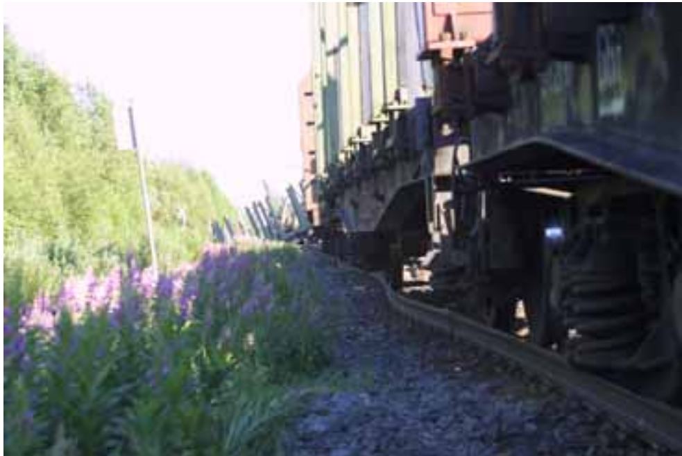
Kuva 2. Neljäntoista venäläisen tavaravaunun suistuminen Hammaslahden ja Tikkalan välissä 16.7.2003. Kuvassa näkyy kiskoihin muodostunut hellekäyrä.
