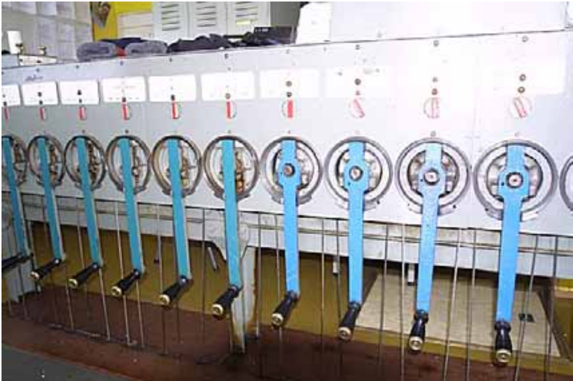
Kuva 2. Matkustajavaunun suistuminen kiskoilta Kemin asemalla 7.2.2003. Kampiasetin-laite kuvattuna tapahtuman jälkeen, kun vaihteita oli jo ehditty kääntää.
