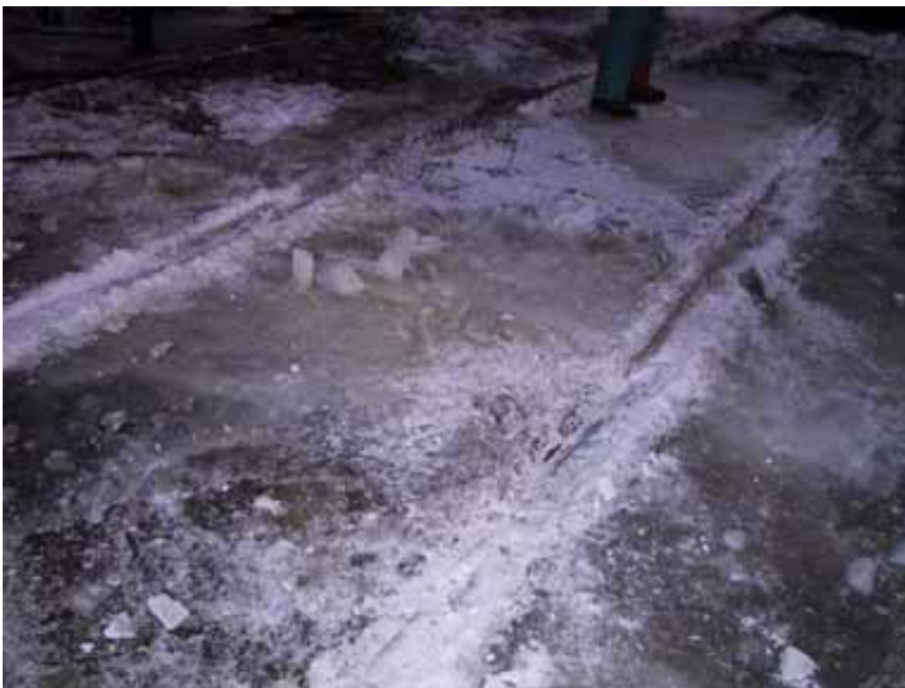
Kuva 4. Kolmen säiliövaunun suistuminen kiskoilta Haminan satamassa 3.1.2003. Teräsjää peittää kiskot kokonaan näkyvistä. Suistumiskohta kuvan keskellä.
