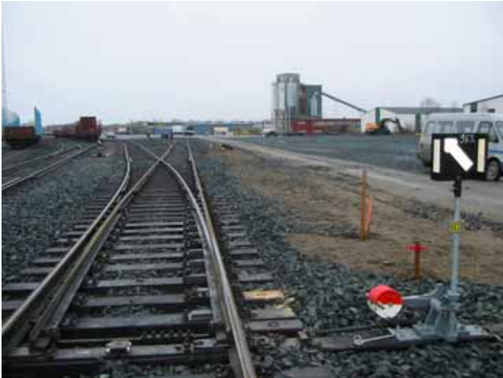
Kuva 4. Vaihde V963 on käännetty kohti raidetta 17.
