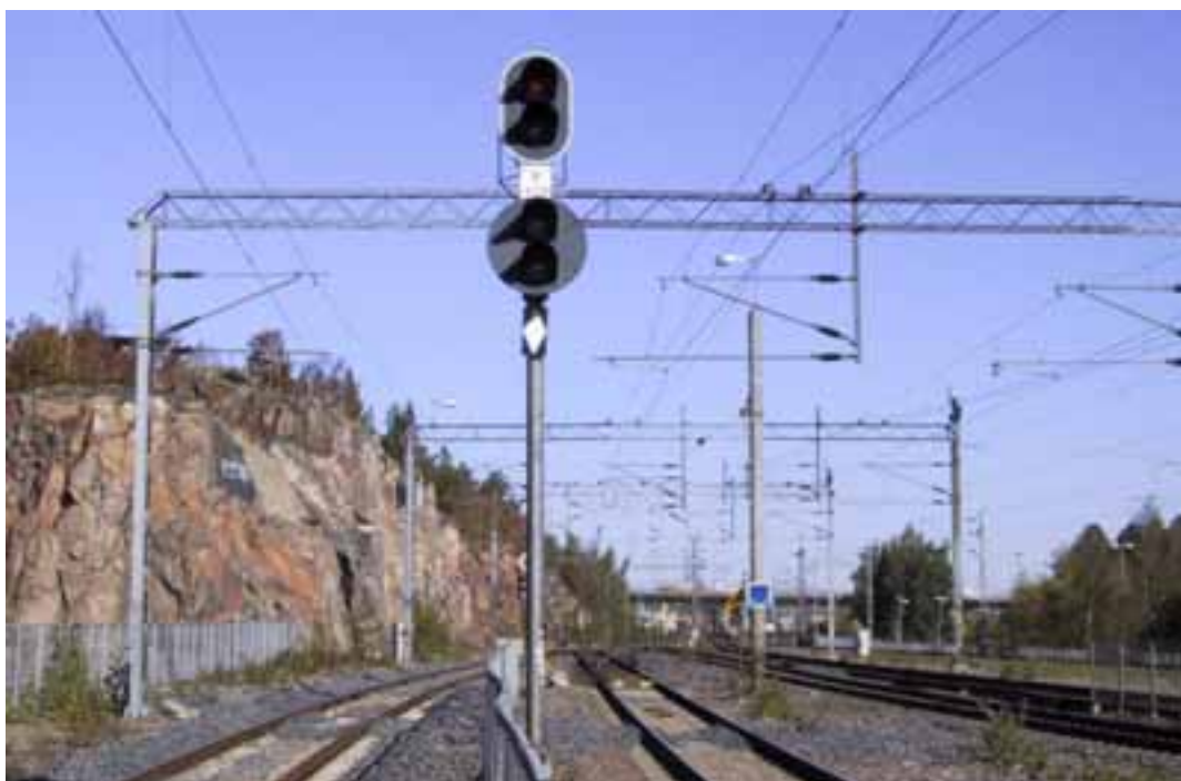
Kuva 6. Vaihtotyökilpi vanhan opastinjärjestelmän mukaisen pääopastimen mastossa Pasilassa.
