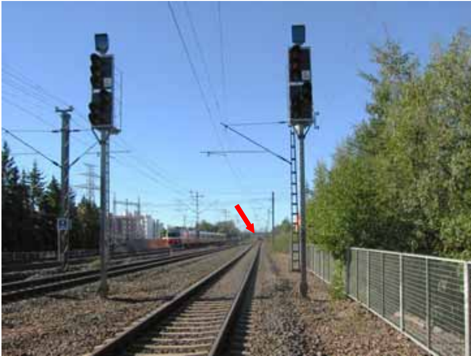
Kuva 3. Rikkoutuneen paikallisjunan siirrossa aiheutunut vaaratilanne ja suistuminen Oulunkylässä 2.9.2002. Oikealla opastin E 581, jonka "seis"-opasteen suistunut yksikkö ohitti. Mastossa ei ole vaihtotyökilpeä. Vasemmalla läntisen keskiraiteen opastin E 582, jonka eteen pikajuna M 22 pysähtyi. Suistunut yksikkö näkyy kuvassa taustalla (nuoli).
