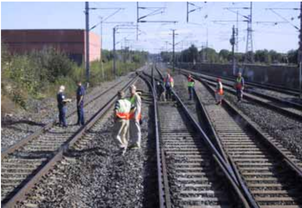
Kuva 4. Rikkoutuneen paikallisjunan siirrossa aiheutunut vaaratilanne ja suistuminen Oulunkylässä 2.9.2002. Kuva suistuneen yksikön takaohjaamosta pohjoisen suuntaan. Suistuminen tapahtui kuvan vaihteessa, jonka kieli on taipunut. Myös betonisissa ratapölkkyissä näkyy suistuneiden pyörien jättämiä vaaleita jälkiä.
