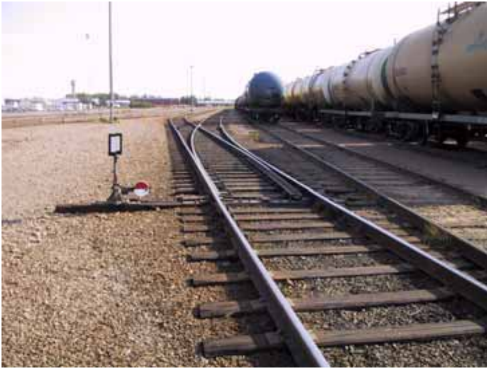
Kuva 2. Vaihtotyöyksikön törmääminen kuormassa oleviin VAK-vaunuihin Haminan satamassa 20.8.2002. Kuvassa vaihteen opastinlevy näyttää väärin. Vaihteenasettimen vastapaino on vaihteenmukaisessa asennossa.
