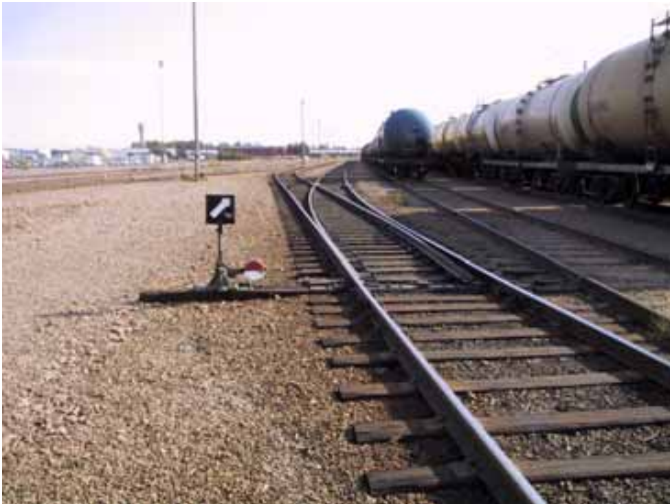
Kuva 3. Vaihtotyöyksikön törmääminen kuormassa oleviin VAK-vaunuihin Haminan satamassa 20.8.2002. Vaihteen opastinlevy näyttää oikein. Huomaa vaihteen asettimen vastapaino samassa asennossa kuin yläkuvassa.
