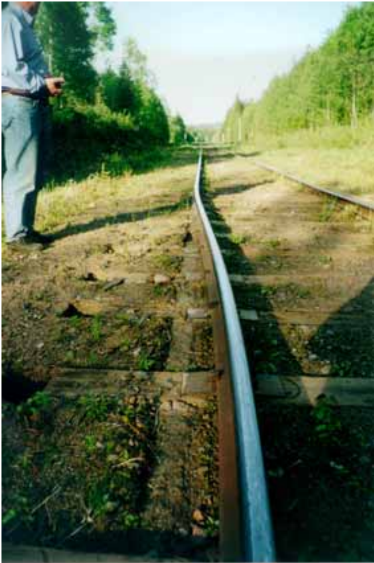
Kuva 3. Kolmen puutavaravaunun suistuminen kiskoilta Huutokoskella 31.5.2002. Rata- pölkkyt siirtyivät sivusuunnassa enimmillään noin 15 cm.
