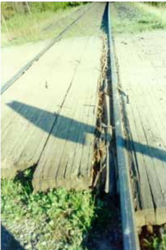
Kuva 7. Tavaravaunun laakerivaurio ja suistuminen Muhoksella 27.5.2002. Kaksi kilometriä Muhoksen asemalta Oulun suuntaan olevan Karhun tasoristeyksen kansi. Kuva on otettu 28.5. aamulla junan kulkusuuntaan.
