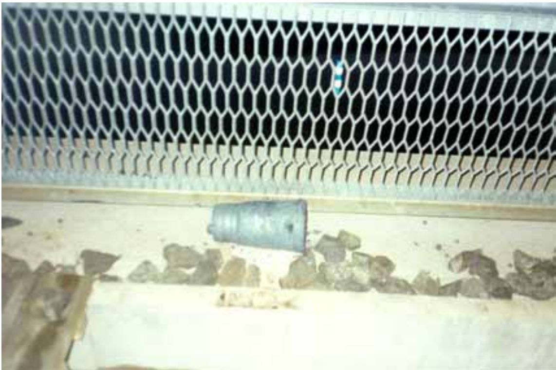
Kuva 5. Tavaravaunun laakerivaurio ja suistuminen Muhoksella 27.5.2002. Irronnut akselinpää Tikkalantien sillalla. Kuvassa näkyy katkenneen pultin pää. Yksi pultti oli laakeripesää avattaessa katkeamattomana laakeripesän sisällä. Todennäköisesti se on kiertynyt auki
