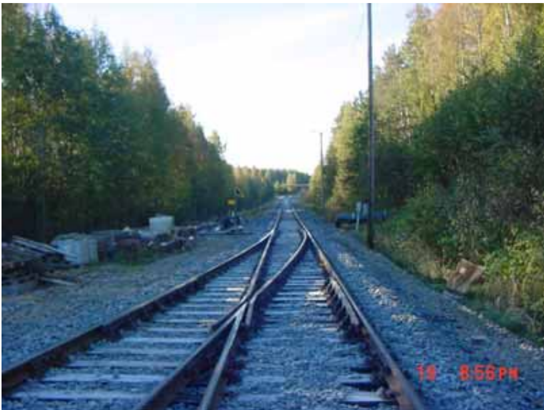
Kuva 4. Matkustajajunan ajo suurella nopeudella väärässä asennossa olleeseen vaihteeseen Kolhossa 19.8.2002 .Kuva ratapihalta matkustajajunan tulosuuntaan.
