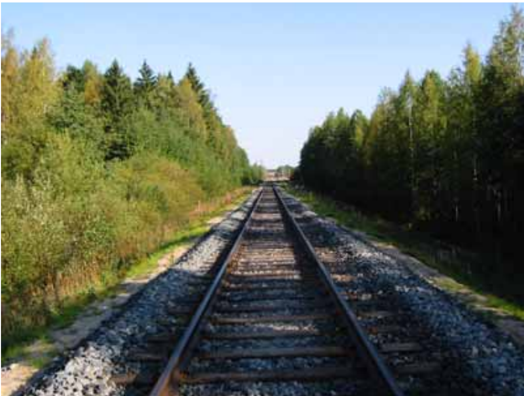
Kuva 2. Matkustajajunan ajo suurella nopeudella väärässä asennossa olleeseen vaihteeseen Kolhossa 19.8.2002. Kuva kohdasta, jossa veturinkuljettaja huomasi vaihteen väärän asennon.
