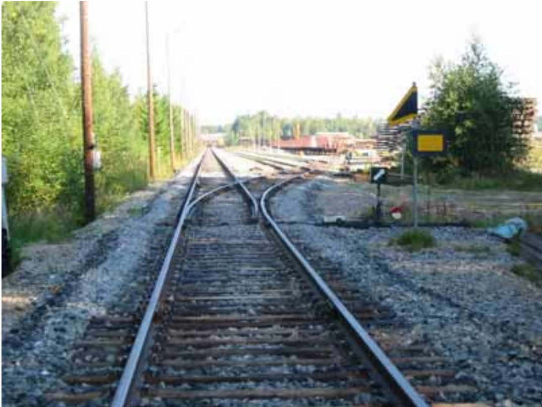
Kuva 3. Matkustajajunan ajo suurella nopeudella väärässä asennossa olleeseen vaihteeseen Kolhossa 19.8.2002. Kolhon vaihteet käännetty kohti raidetta 2.
