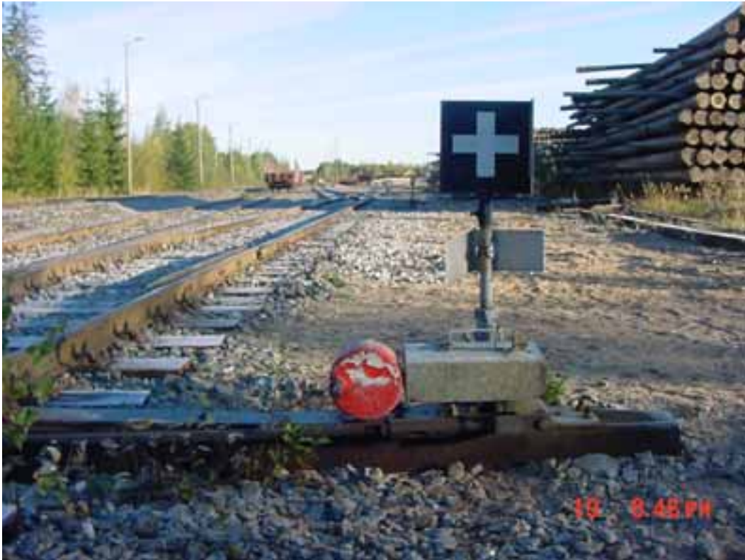
Kuva 5. Matkustajajunan ajo suurella nopeudella väärässä asennossa olleeseen vaihteeseen Kolhossa 19.8.2002. Raiteensulku SpI suojaelteen, jonka alla varmistuslukkolaitoksen avaimia säilytettiin.
