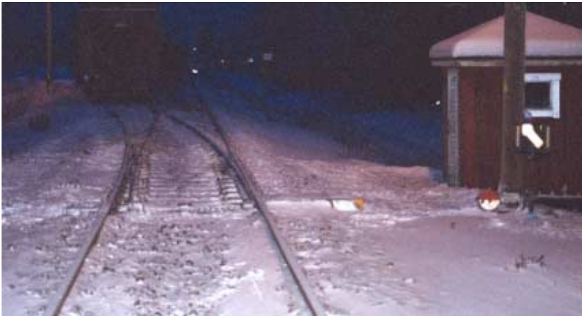
Kuva 8. Kolmen tavaravaunun suistuminen kiskoilta Rauhassa 26.1.2001. Vaihte V1 junan tulosuunnasta katsottuna. Vaihte käännettynä kohti raidetta 2. Oikealla vaihdekoju sekä vaihteenkääntäjä.
