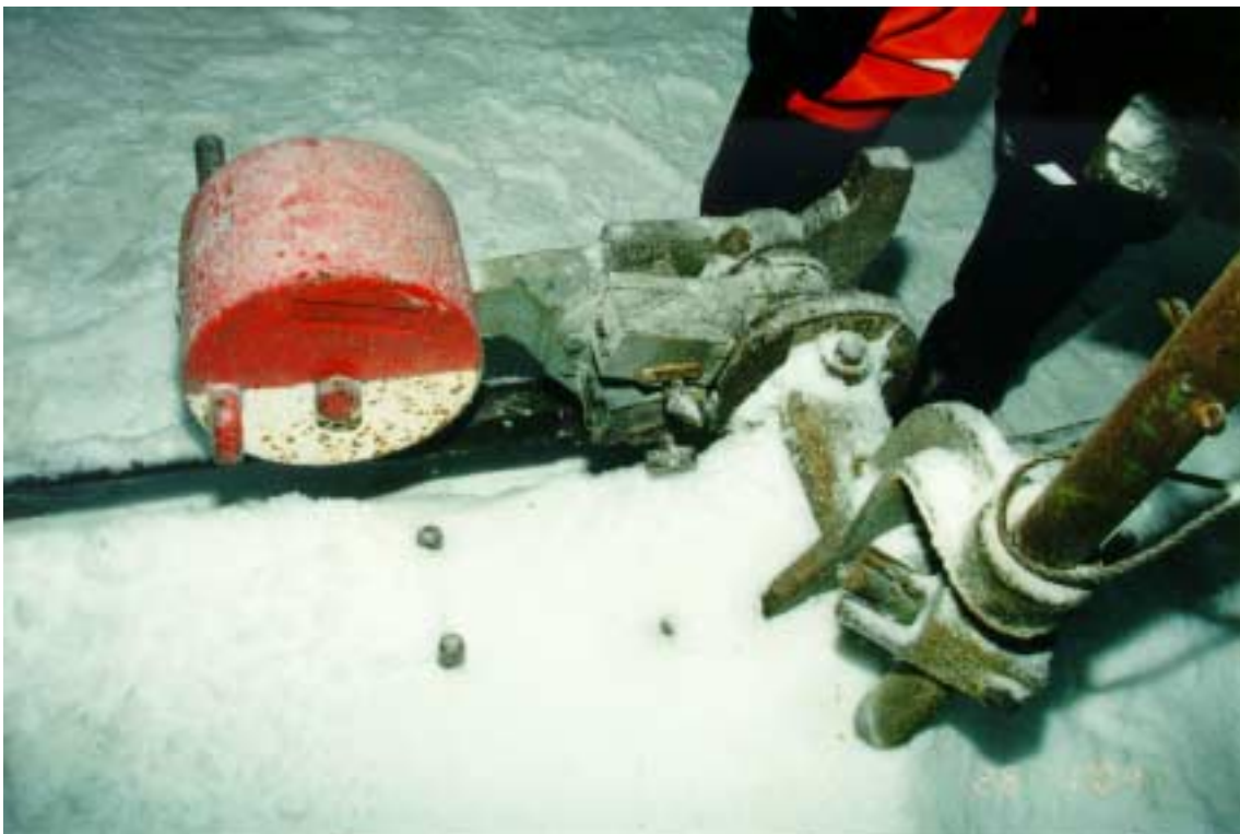
Kuva 9. Kolmen tavaravaunun suistuminen kiskoilta Rauhassa 26.1.2001. Vaihteenkääntäjä. Kumpikin avain on pesässään lukituslaitteessa.
