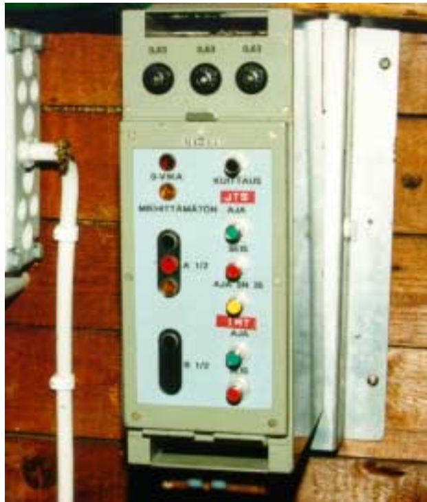
Kuva 6. Kolmen tavaravaunun suistuminen kiskoilta Rauhassa 26.1.2001. Ohjaustaulusta saa pääopastimeen A½ Joutsenon suunnasta (JTS) joko "aja"-, "aja sn35"- tai "seis"-opasteen, kun taas toisessa päässä ratapihaa olevaan opastimeen B½ Imatran suunnasta (IMT) joko "aja"- tai "seis"-opasteen.
