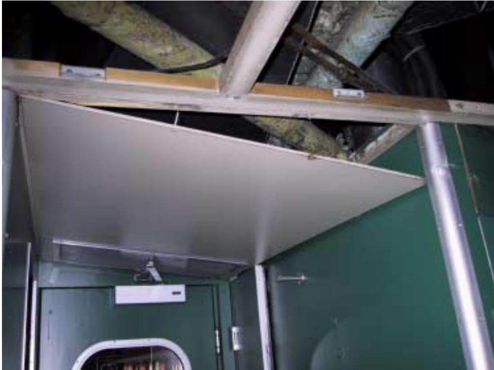
Kuva 5. Veturin törmääminen paikallaan olleen matkustajajunan perään Tampereella 2.11.2001. Vaunujen kattoluukkuja irtosi ja avautui lukituksistaan.
