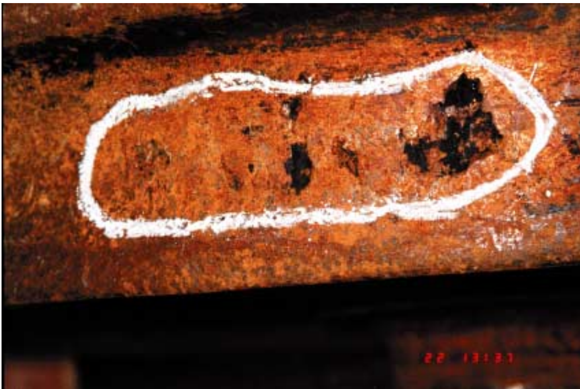
Kuva 11. Tavarajunan suistuminen kiskoilta Jalasjärvellä 19.2.1999. Pyörässä, jonka vierestä akseli katkesi, oli noin 180 mm pitkä ja enimmillään 7 mm syvä lovi. Loven vuoksi laakerointiin kohdistui junan kulkiessa liian suuri pystysuuntainen isku-mainen kuormitus, minkä seurauksena laakeri ylikuumentui, vaurioitui ja juuttui.
