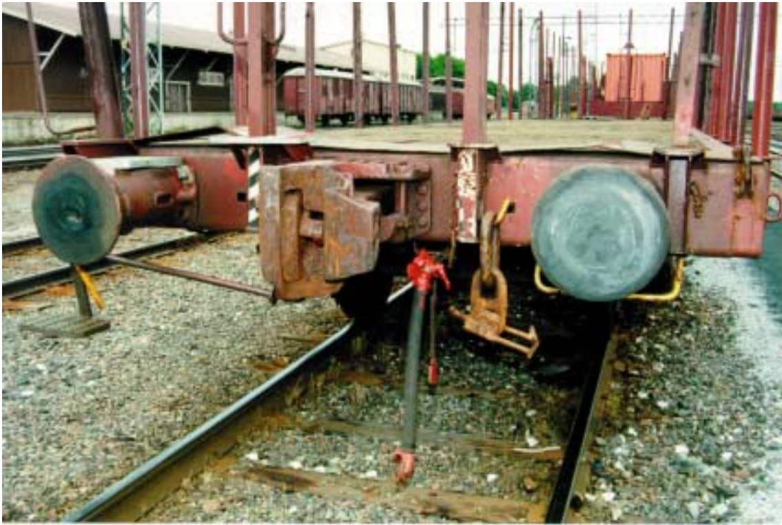
Kuva 2. Junamiehen loukkaantuminen vaihtotyössä Lappeenrannassa 12.8.1999. Raitteella 4 seisoneen ensimmäisen vaunun pääty. Vaunu on varustettu automaattikytkimellä.
