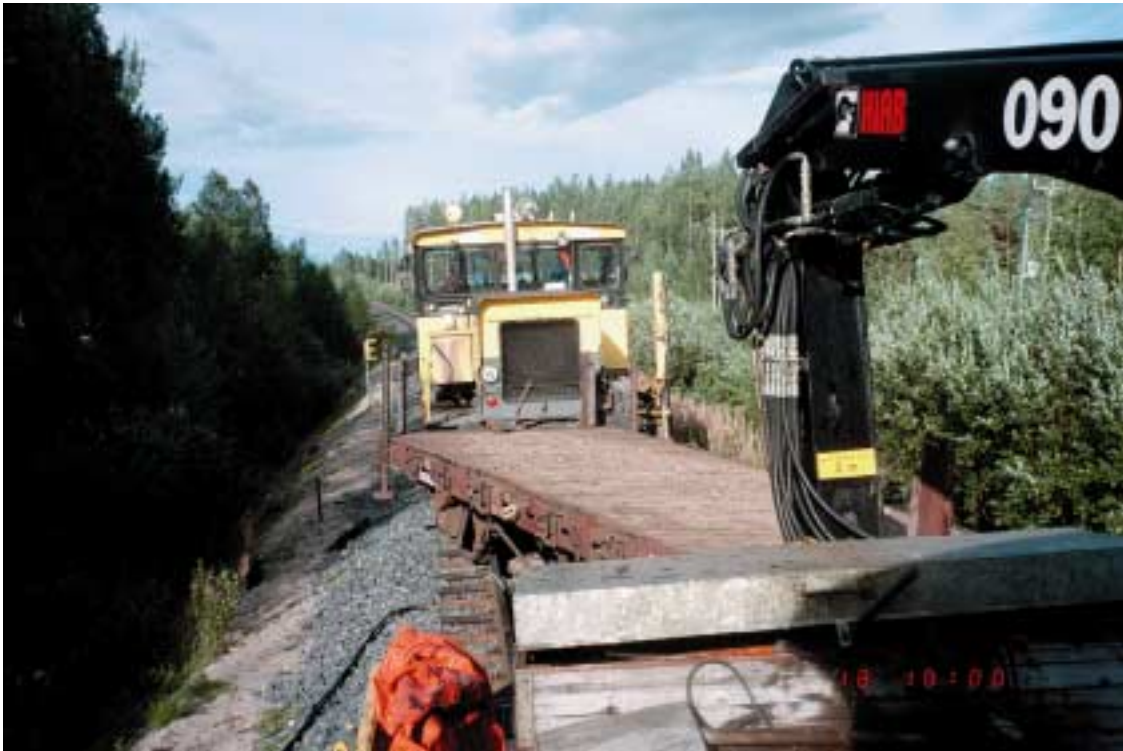
Kuva 4. Kahden ratakuorma-auton yhteentörmäys Korkeakoskella 18.8.1999. Kuva Tka 155:n lavalta Pirttikankaan ja Vilppulan suuntaan kuvattuna. Tasoristeyksen hälytysalueen alkua ilmaiseva eristysmerkki näkyy radan vasemmalla puolella.
