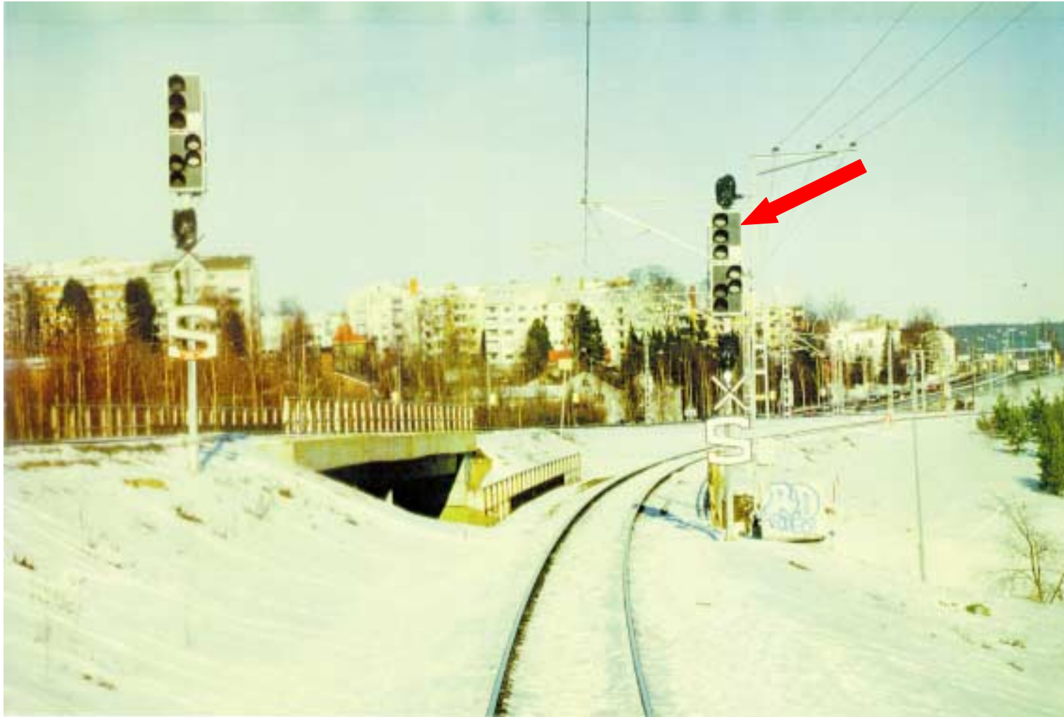
Kuva 4. Junaonnettomuus Jyväskylässä 6.3.1998. 440 metrin päässä suistumisvaihteesta pääopastimessa (nuoli) paloi kelta-vihreä opaste, joka tarkoittaa sitä, että kulkutiellä seuraavana olevassa vaihteessa suurin sallittu nopeus on 35 km/h. Junan nopeus oli vielä tässä 128 km/h. Tolpassa oleva rasti ja S-merkintä ilmaisee, ettei kyseinen opastin ollut käytössä kuvaushetkellä.
