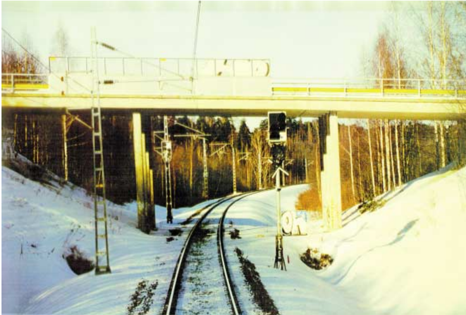
Kuva 2. Junaonnettomuus Jyväskylässä 6.3.1998. Esiopastin, jossa paloi onnettomuusjunalle vihreä – keltainen opaste (tässä opastin ei ole käytössä). Opaste ilmaisi kulkutiellä seuraavana olevan vaihteen, jossa suurin sallittu nopeus oli 35 km/h. Esiopastimelta on matkaa suistumisvaihteeseen 2,2 km. Junan nopeus oli tässä vielä 137 km/h.
