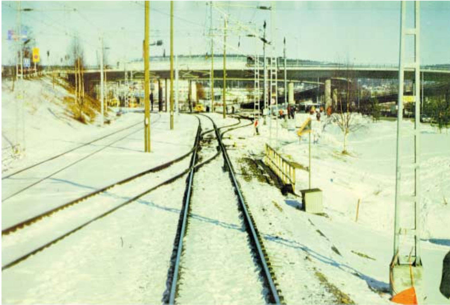
Kuva 6. Junaonnettomuus Jyväskylässä 6.3.1998. Juna tuli hätäjarrutettuna oikealle johtavaan vaihteeseen nopeudella 110 km/h, suurin sallittu nopeus olisi ollut 35 km/h. Suistumisvaihteesta suoraan ajettaessa 420 m päässä on vaihte, jossa suurin sallittu nopeus on 80 km/h. Suurin osa etelästä Jyväskylään saapuvista matkustajajunista ohjataan sinne.
