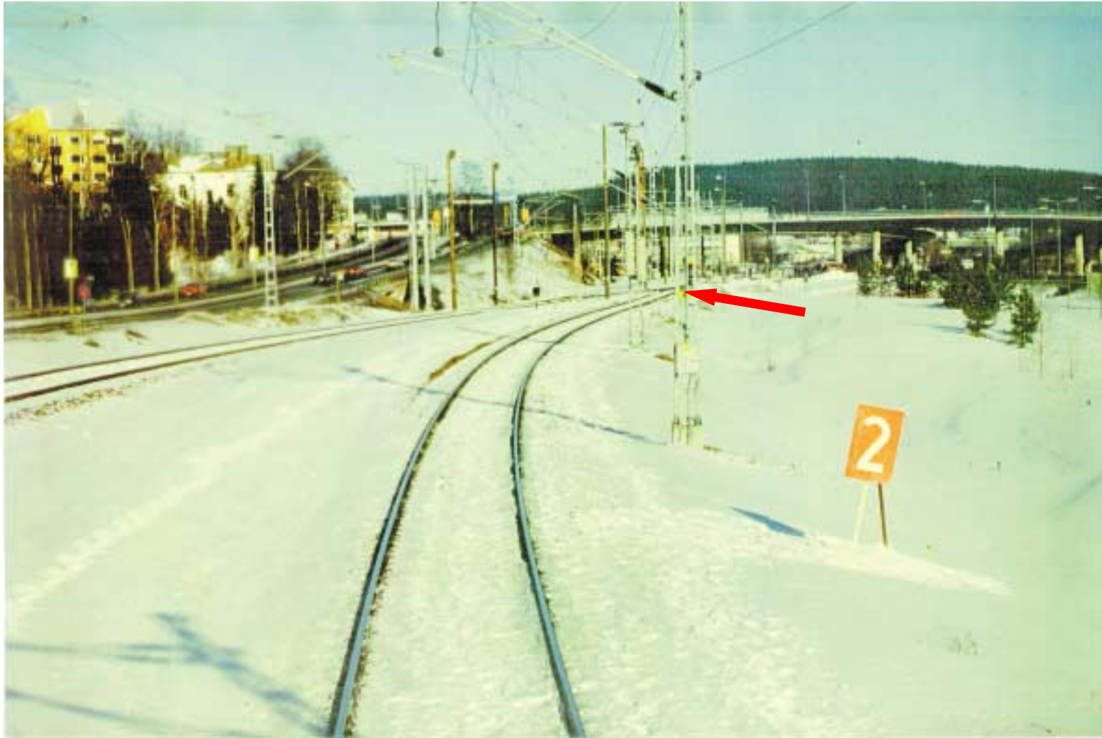
Kuva 5. Junaonnettomuus Jyväskylässä 6.3.1998. Kuljettaja tehosti 320 metriä ennen suistumisvaihdetta jarrutusta (2) ja vain kaksi sekuntia tämän jälkeen hän aloitti hätäjarrutuksen nopeudesta 127 km/h. Jarruviiveen takia hätäjarrutus alkoi tehoista vasta noin 100 metriä ennen onnettomuuspaikkaa (nuoli).
