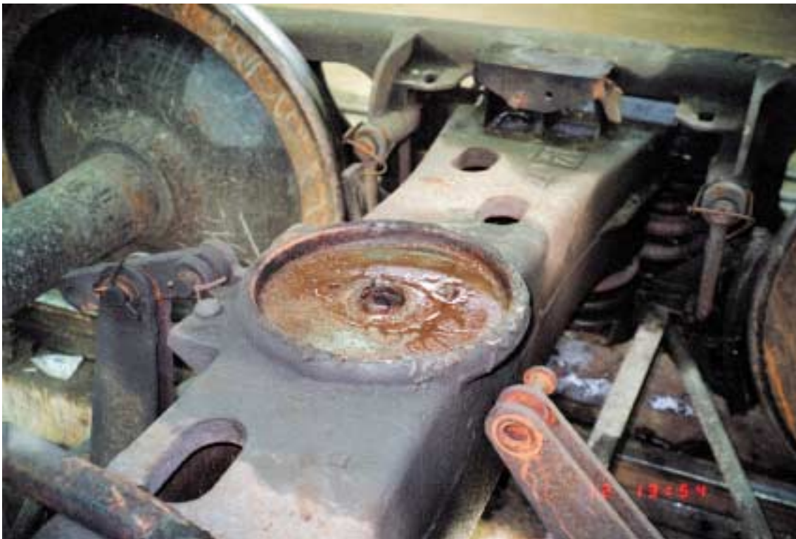
Kuva 7. Tavaravaunun suistuminen kiskoilta Lauritsalassa 7.11.1997. Telissä kiinni oleva telikeskiön osa.
