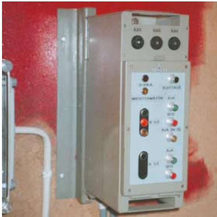
Kuva 5. Tavaravaunun suistuminen kiskoilta Lauritsalassa 7.11.1997. Vaihdekojussa 2 oleva opastimien ohjaustaulu.
