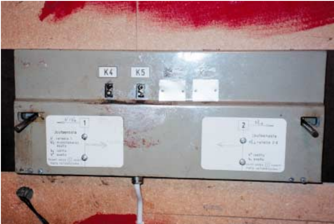
Kuva 4. Tavaravaunun suistuminen kiskoilta Lauritsalassa 7.11.1997. Vaihdekojussa 2 oleva kosketinlaite.
