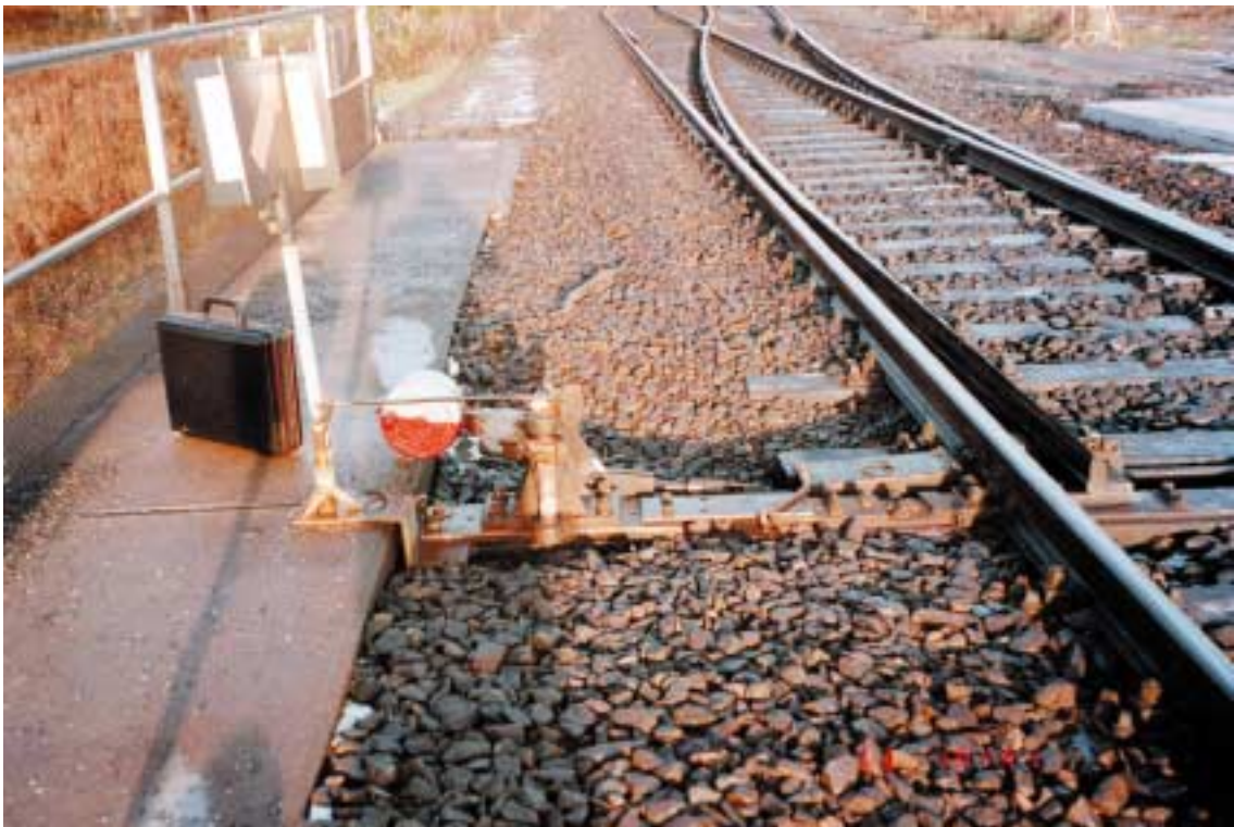
Kuva 3. Tavaravaunujen suistuminen kiskoilta Porissa 30.10.1997. Vaihte siinä asennossa, missä se oli onnettomuuden jälkeen. Vaihteenkääntäjän "limpun" varmistushaka ei ole ollut kiinni.
