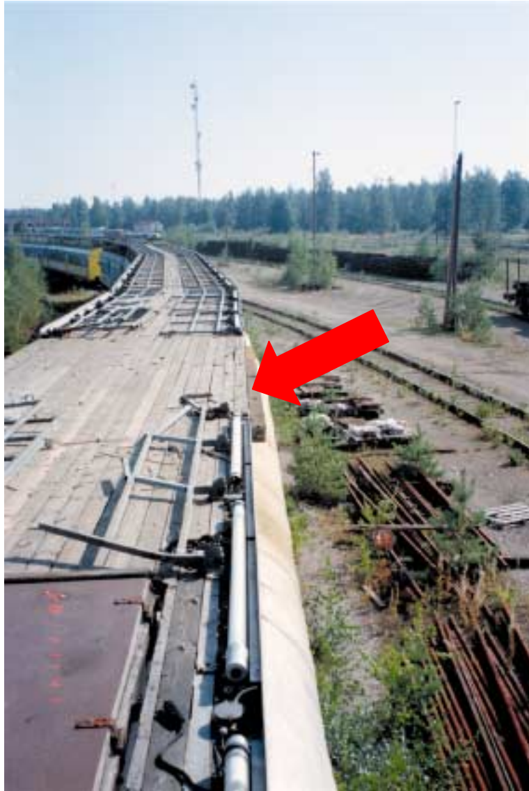
Kuva 6. Johdonvetojunan törmäminen sähkörataportaaliin Hämeenlinnassa 27.8.1997. Näkymä johdonvetojunan kattolavalta. Etualalla rikkoutunut kaide. Edellisessä kuvassa oleva rikkoutunut kaide oli irronnut siirtyvästä sivulavasta (merkitty nuolella).
