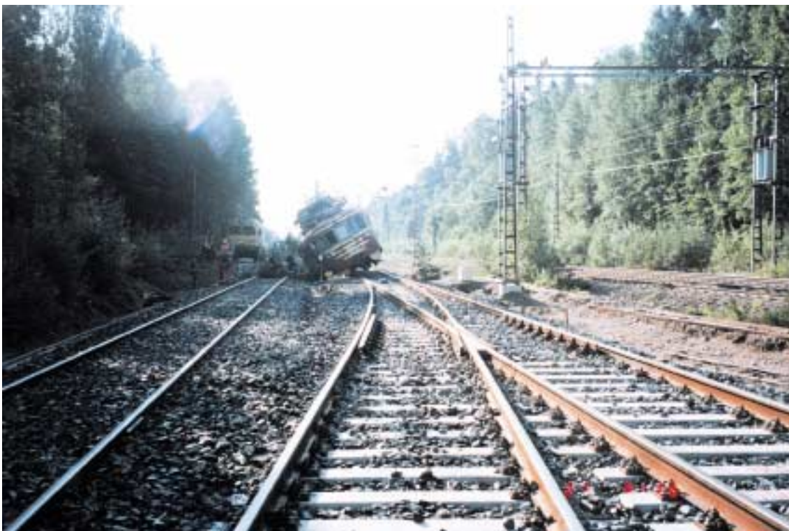
Kuva 4. Ttv:n suistuminen Saunakalliossa 27.8.1997. Vaihde V221 ja sen takana kiskoilta suistunut Ttv. Figure 4. Derailment of work machine (Ttv) at Saunakallio, on August 27, 1997. Point V221 and the derailed work machine at the back.
