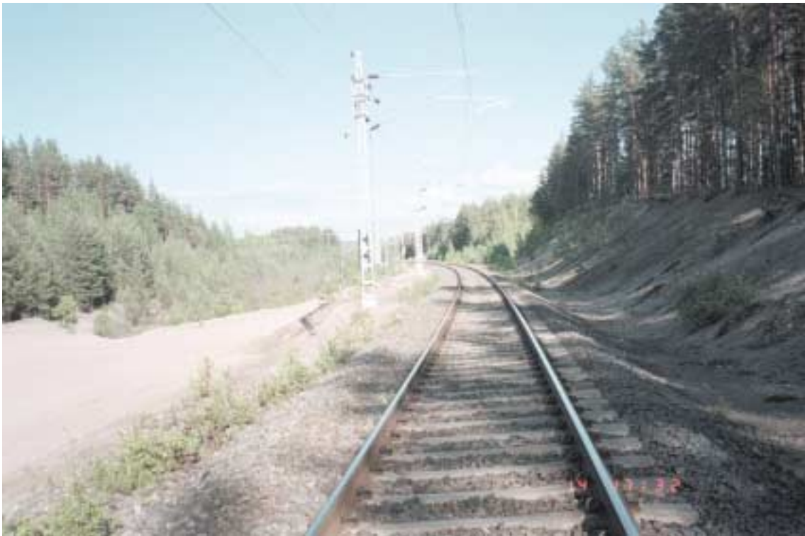
Kuva 2. Vaaratilanne Naarajärvellä 11.6.1997. Näkymä tavarajunan tulosuunnasta kohti ratapihaa; kohdasta, josta vaihde 1 ja osa ratapihaa alkavat näkyä (km 499), vaihtotyöyksikkö ei näkynyt.
