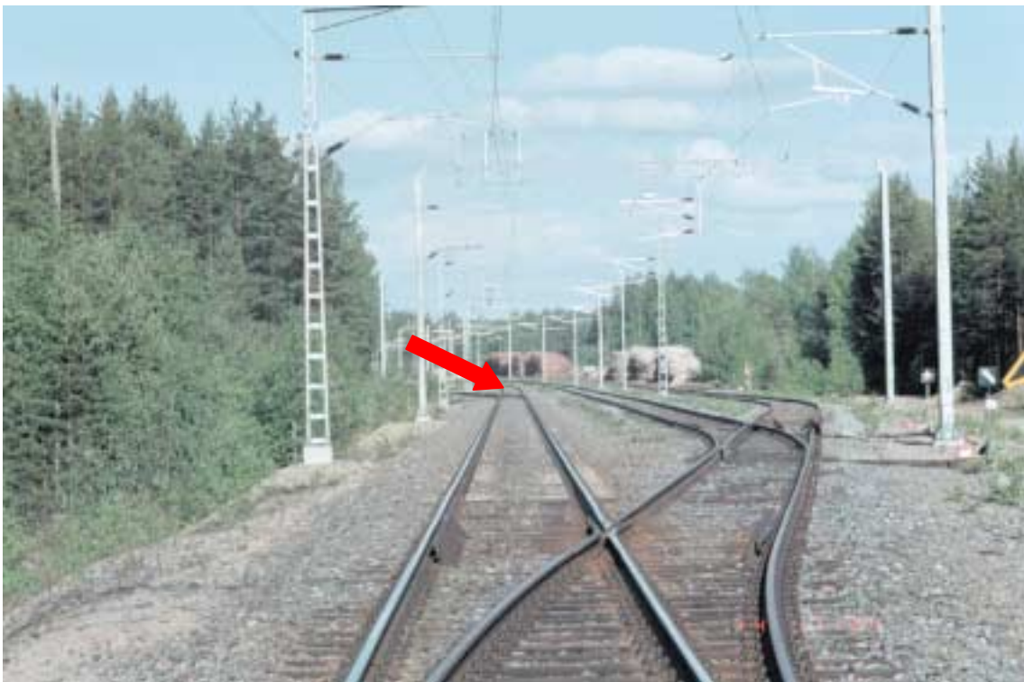
Kuva 3. Vaaratilanne Naarajärvellä 11.6.1997. Näkymä tavarajunan tulosuunnasta, vaihteen 1 päältä, kohti ratapihaa. Vaihtotyöyksikön perä oli nuolella merkityssä kohdassa.
