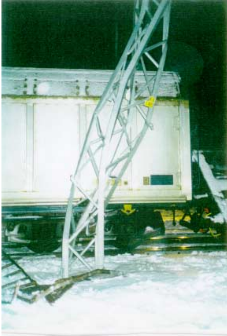
Kuva 3. Vaurioitunut sähkörataportaalin pylväs.
