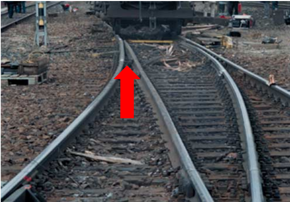
Kuva 7. Etutelin oikeanpuoleiset pyörät kiiloutuivat tukikiskon ja vaihteen kielen väliin.
