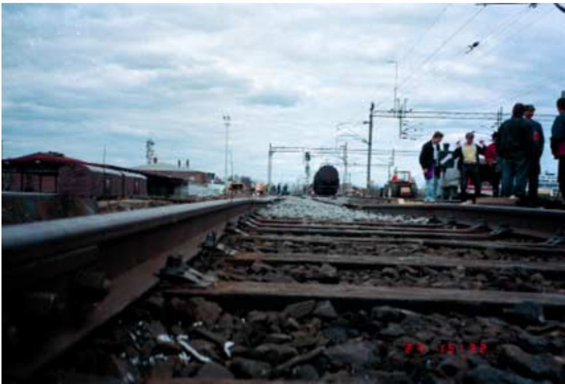
Kuva 11. Vaihte V70 onnettomuuden jälkeen. Kielen kärjen kohdalla vasen kisko 8 cm alhaalla ja oikea 11 cm.
