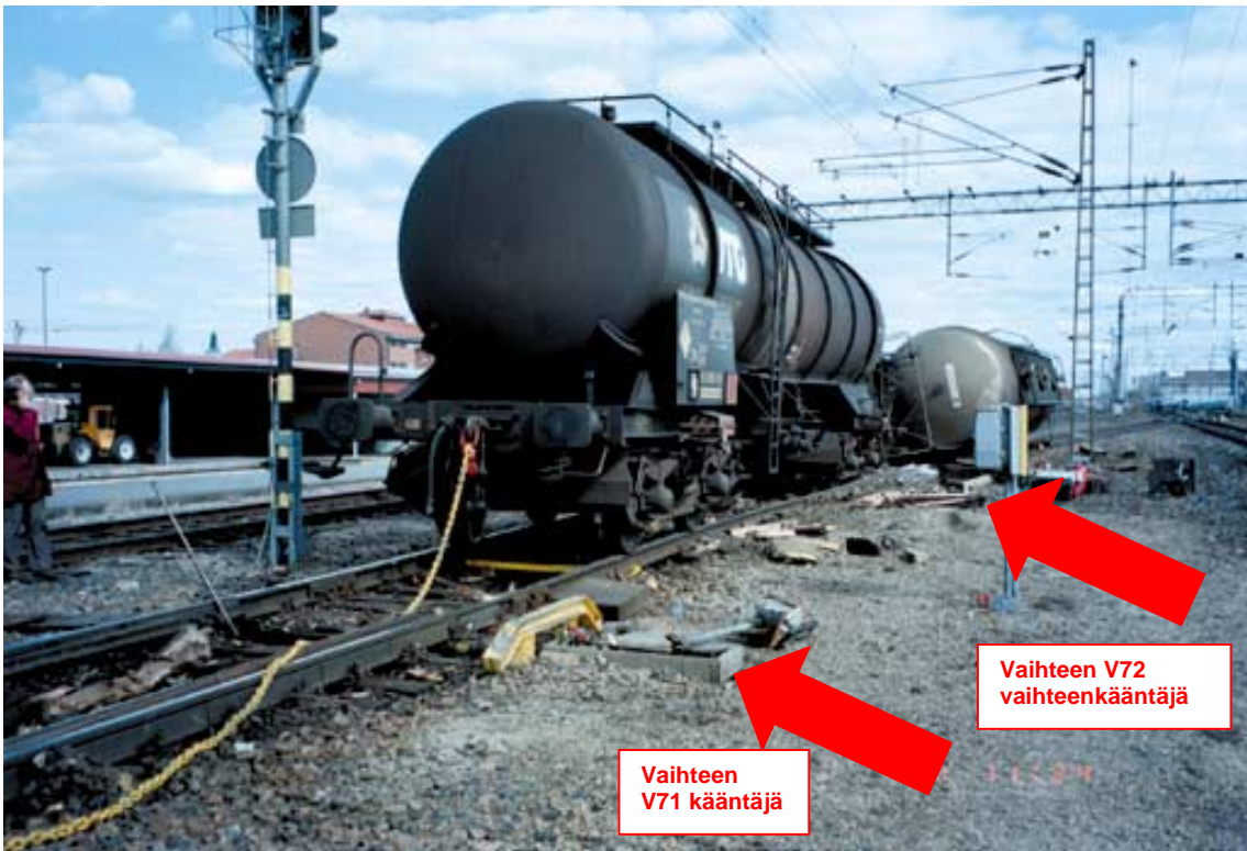
Kuva 9. Kaatuneen vaunun säiliö ja nosto/vetokorvake rikkoivat vaihteiden V71 ja V72 vaihteenkääntäjät.
