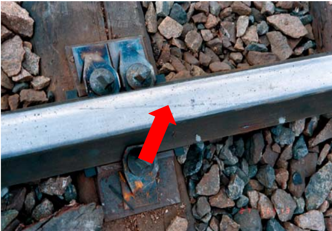
Kuva 5. Pyöränlaipan tekemä ylimenojälki suoraan menevän raiteen oikean kiskon päällä (34 m kielen kärjestä).
