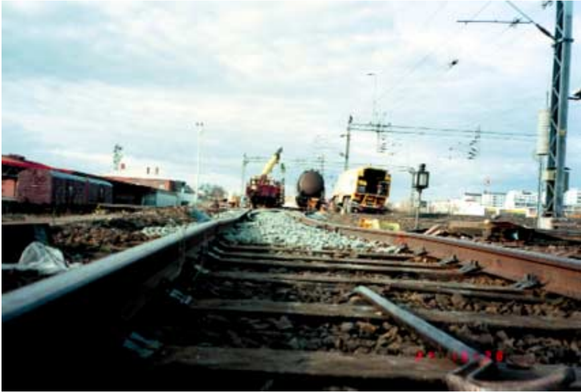
Kuva 12. Vaihde V70 korjauksen jälkeen. Kielen kärjen kohdalla vasen kisko 5,5 cm alhaalla ja oikea 9,5 cm.
