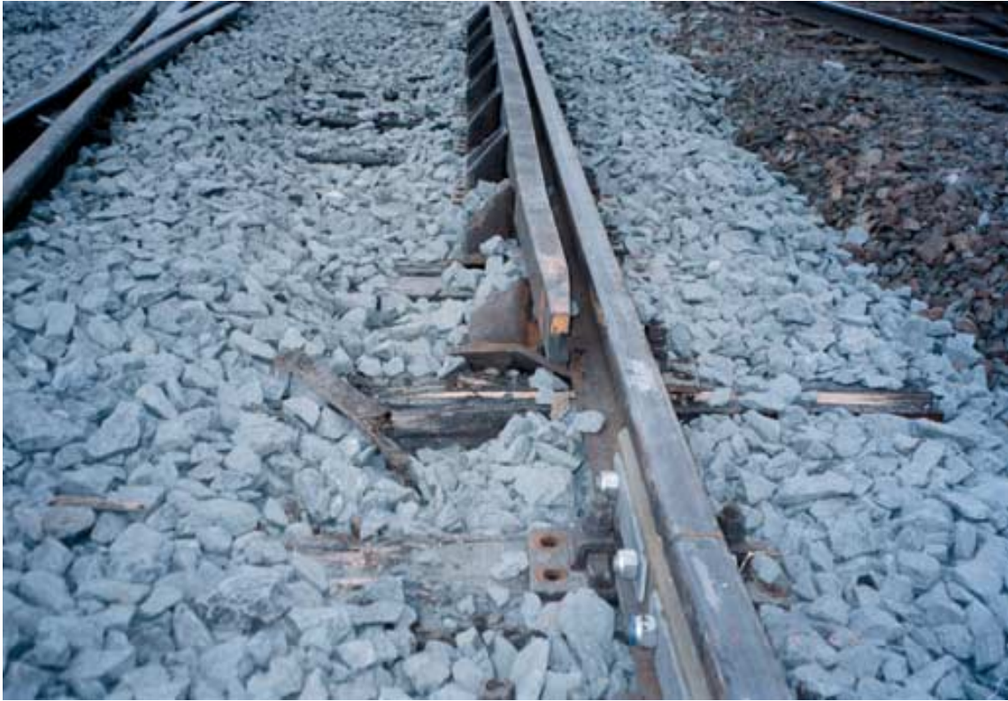
Kuva 4. Oikeanpuoleinen pyörä pudonnut kiskolta (jälki lähimpänä olevan pultin päässä) ja mennyt vastakiskon sisäpuolelle.
