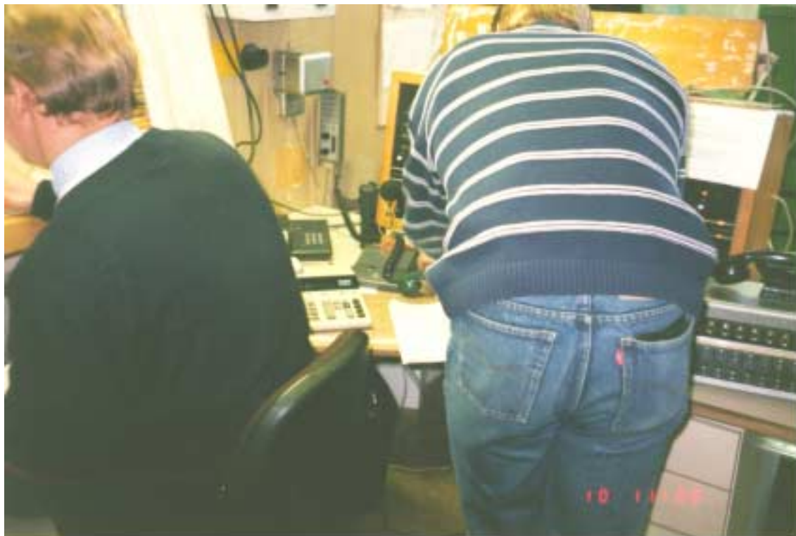
Kuva 7. Junasuorittaja työssään asetinlaitteella.
