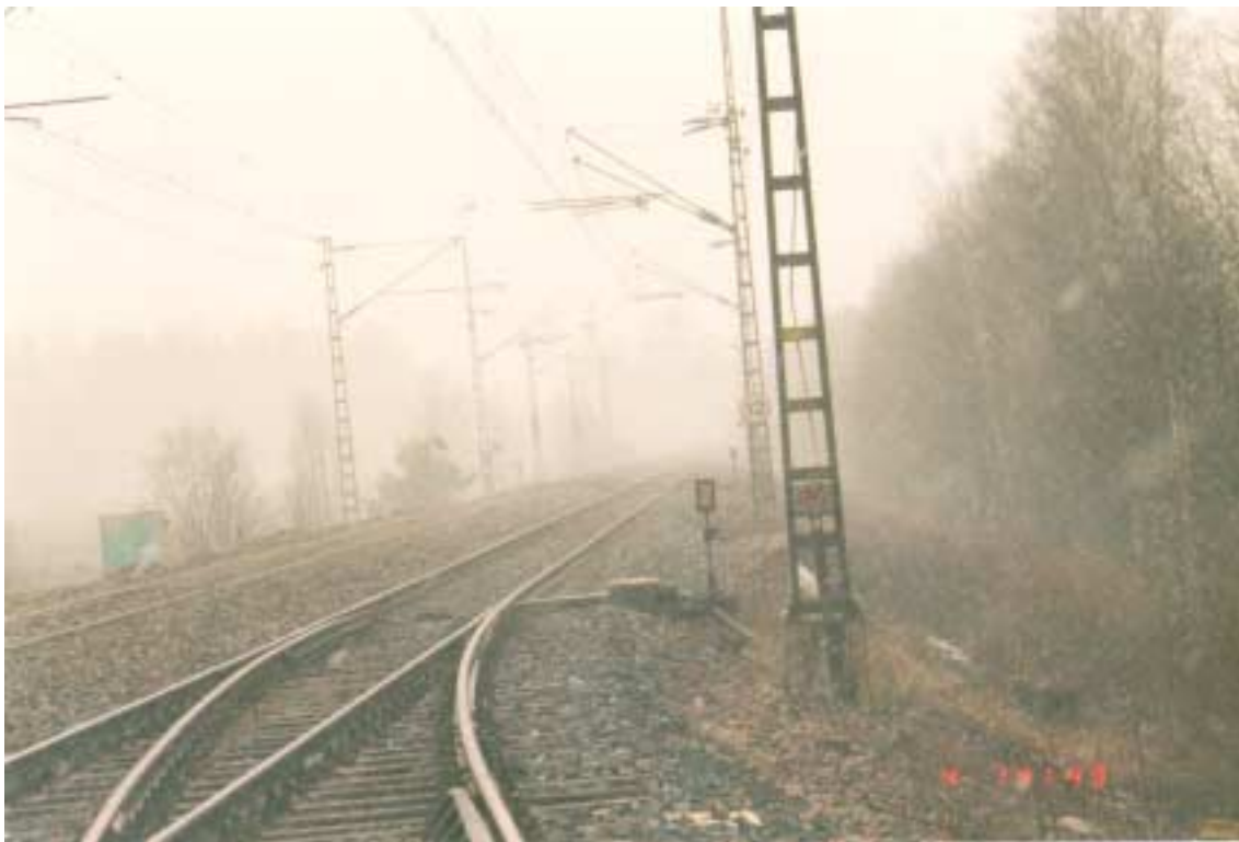
Kuva 5. Näkymä raiteelta 3, vaihteen 6 päältä katsottuna kohti Kiloa. Vaihte 4 on 120 km/h-nopeusrajoitusmerkin jälkeen. Vaihte 2 on siitä vasemmalle. Nopeusrajoitusmerkin olisi pitänyt olla vaihteen 4 jälkeen.
